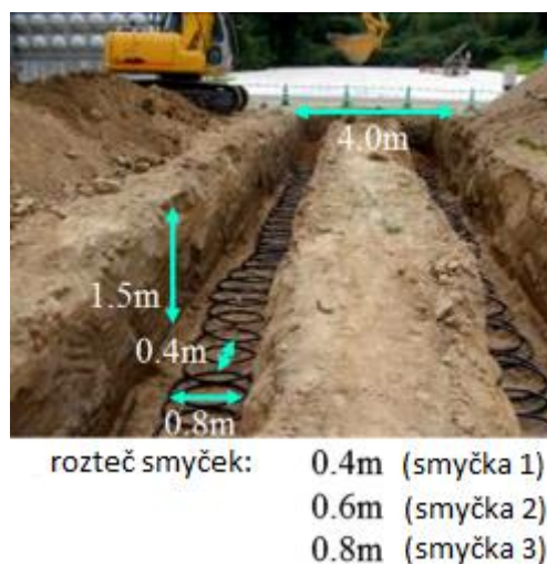
Obr. 4 Uložení tepelného výměníku typu Slinky (Fujii a kol., 2010)
