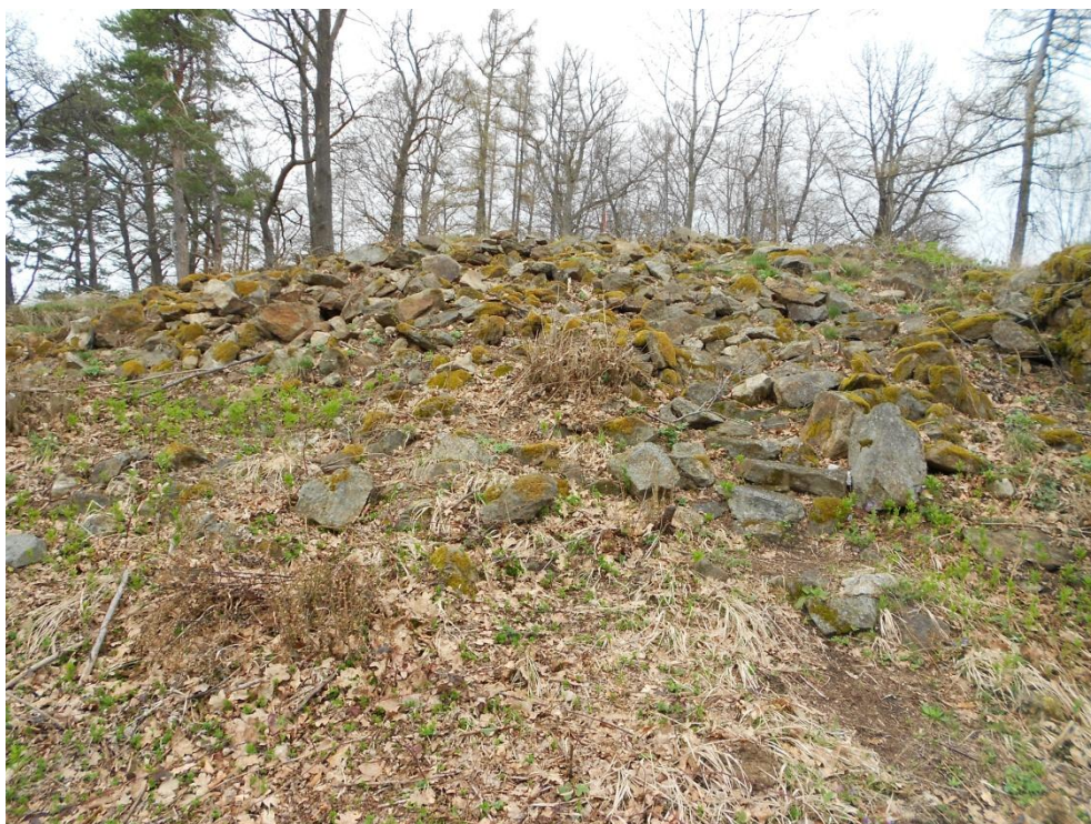
Obr. 66 – Vitějovice. Připravený stavební materiál uvnitř dispozice hradu (foto autor).
