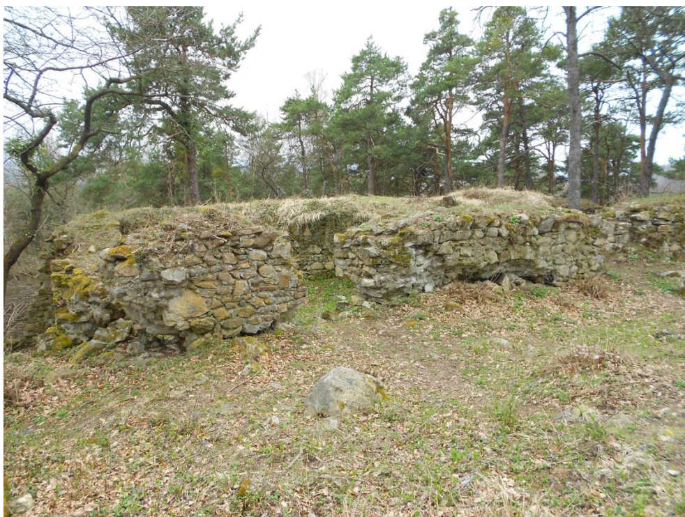
Obr. 65 – Vitějovice. Rovné koruny zdí svědčí o zastavení stavebních prací v úrovni prvního patra (foto autor).
