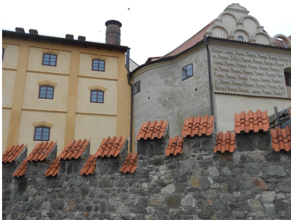
Obr. 19 – Pozůstatek věže v jižní části dispozice. Je patrné velice malé předsunutí před samotnou hradbu (foto autor)
