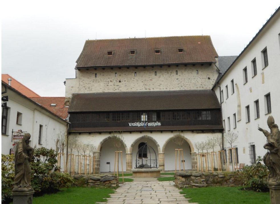
Obr. 41 – Západní křídlo Hradu v Písku, pohled od východu (foto autor).
