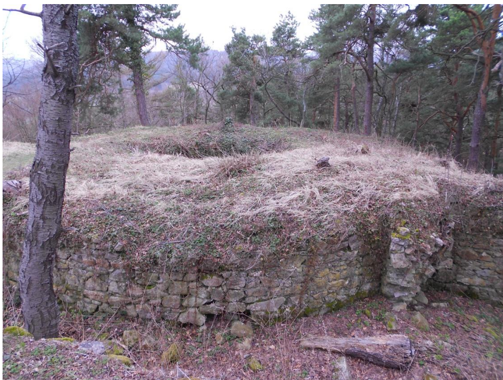
Obr. 63 – Okrouhlá věž stojící na jihozápadní části dispozice, pohled severu (foto autor).
