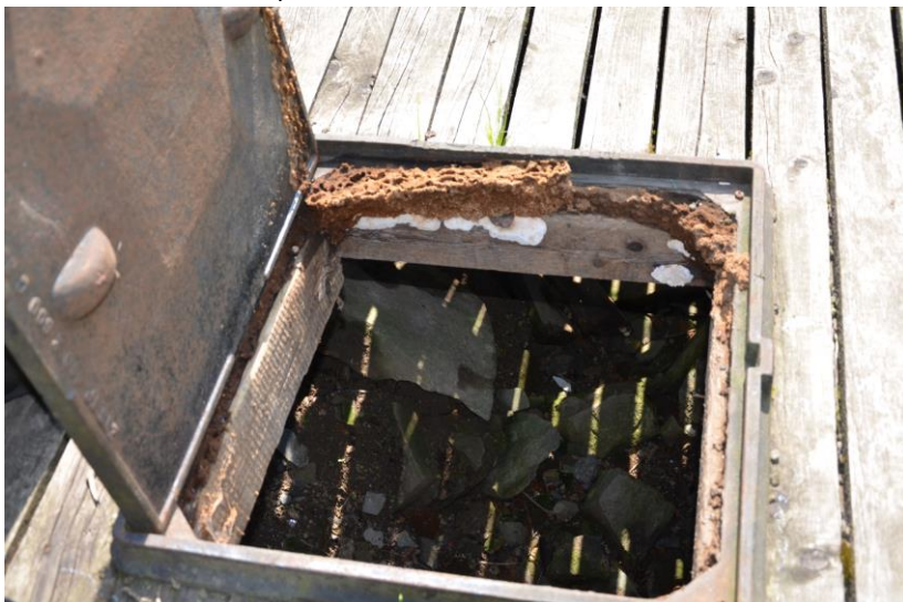
Obr. 36. Vchod do podzemní chodby (Dominika Balatková, 2014)
