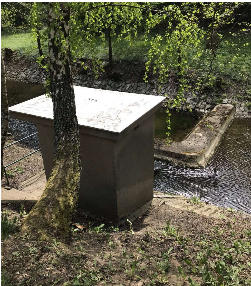
Obr. 2.17 LG Letovice pod hrází a upravené koryto toku
