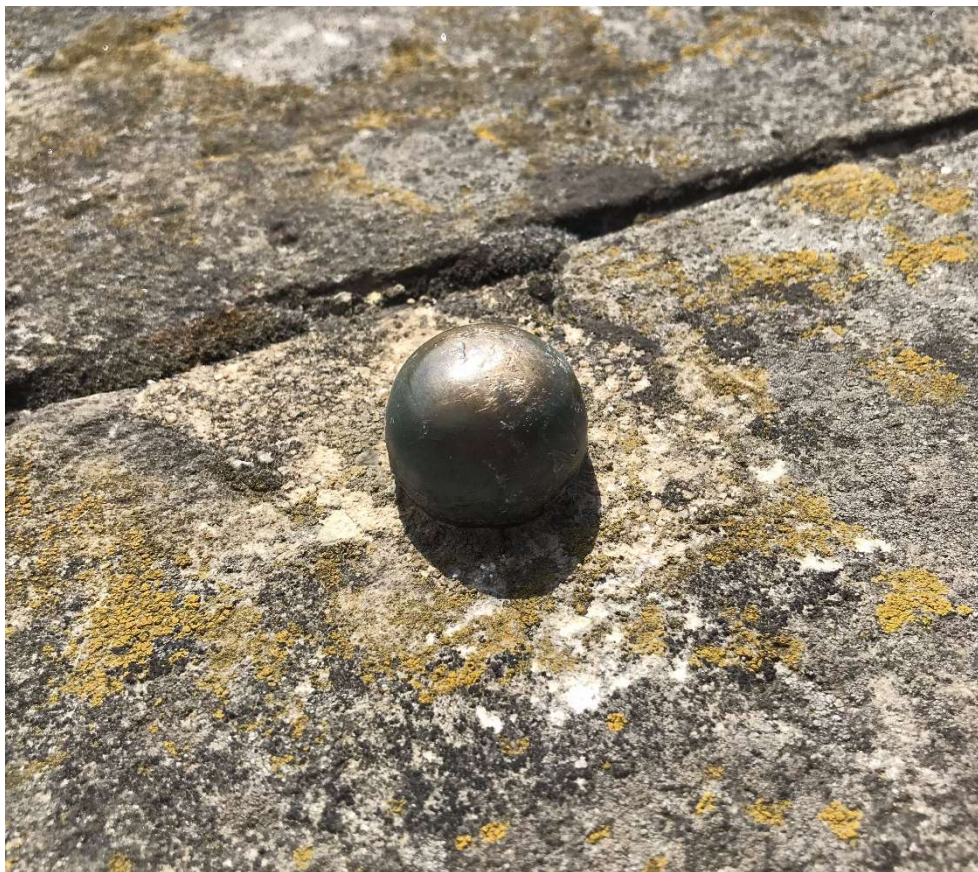
Obr. 2.32 Kontrolní nivelační bod K1 na vlnolamu
