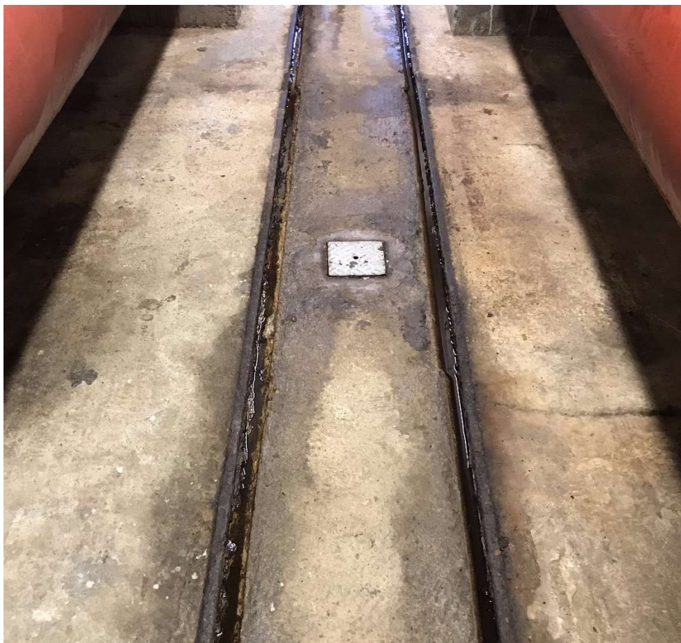
Obr. 2.34 Poklop nivelačního bodu 12 v chodbě spodních výpustí
