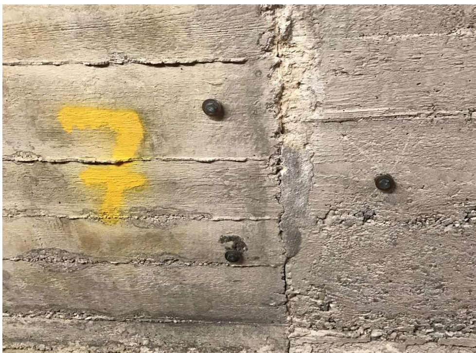
Obr. 2.36 Deformetrická základna D7
