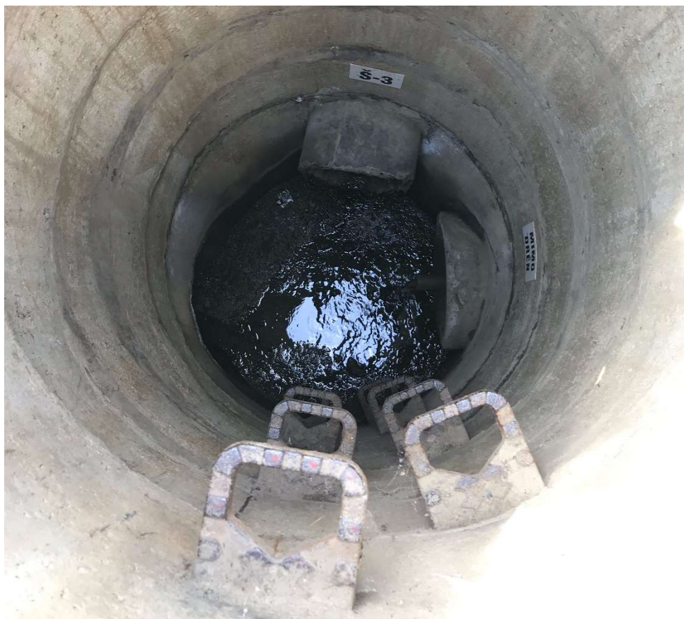
Obr. 2.27 Pohled do kontrolní šachty KŠ3
