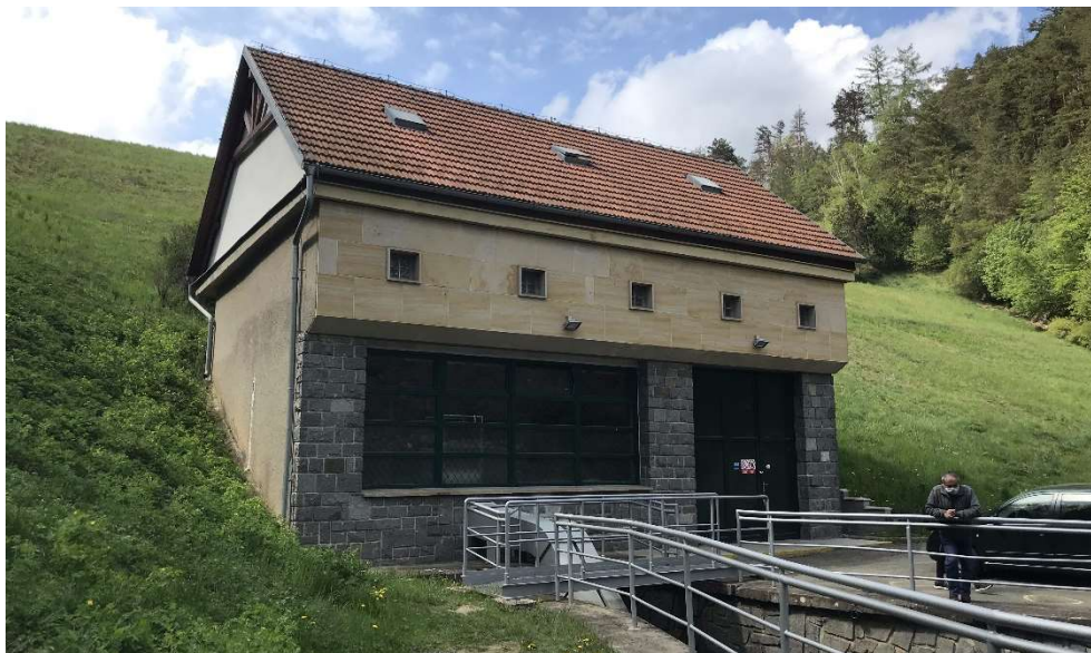
Obr. 2.15 Objekt MVE spolu se strojovnou spodních výpustí
