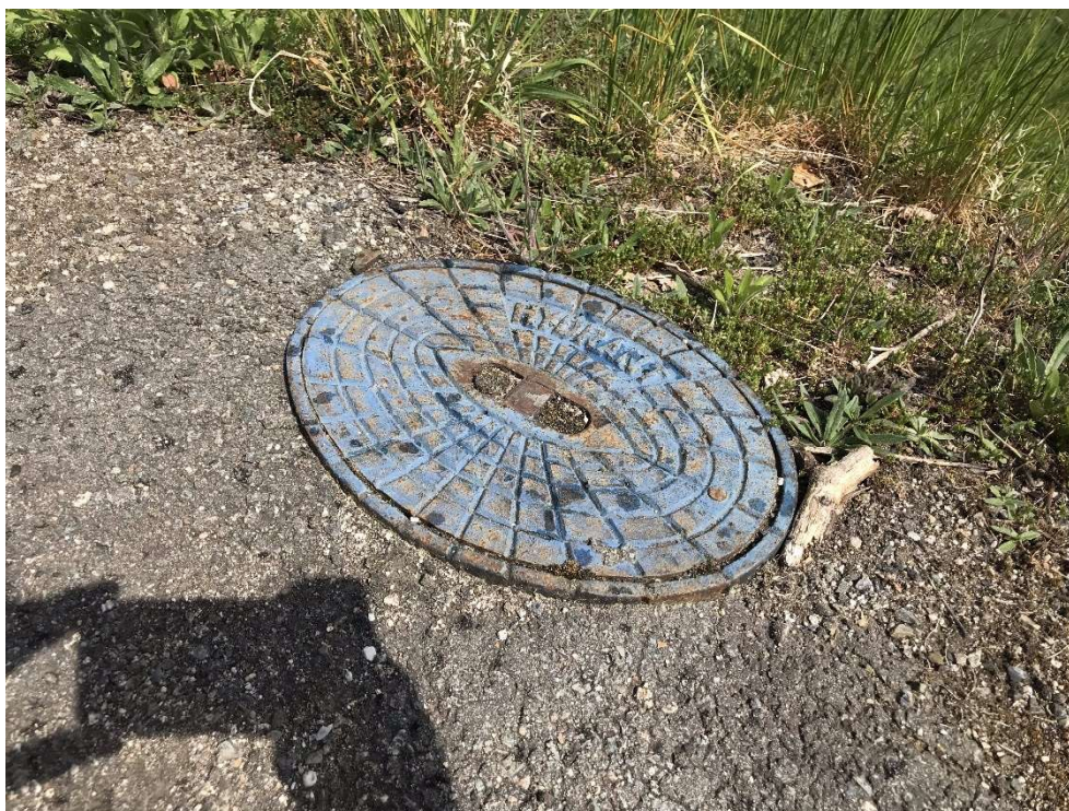
Obr. 2.33 Poklop nivelačního bodu K12 při vzdušní straně
