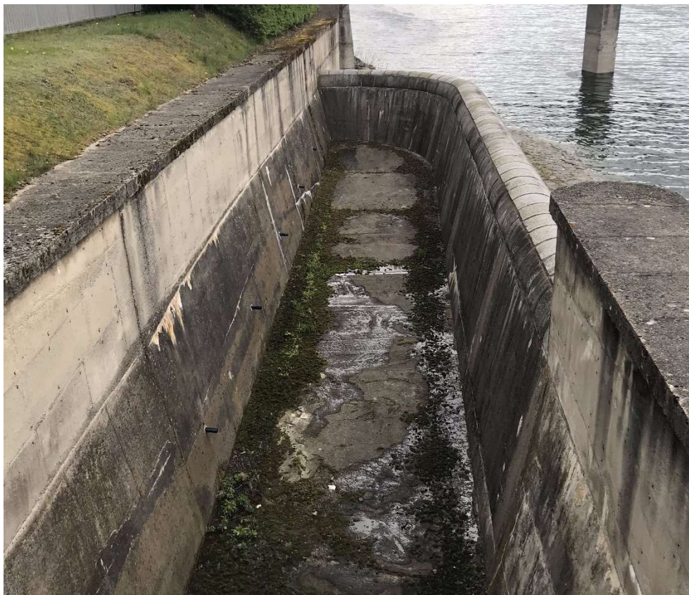
Obr. 2.12 Bezpečnostní přeliv se spadištěm
