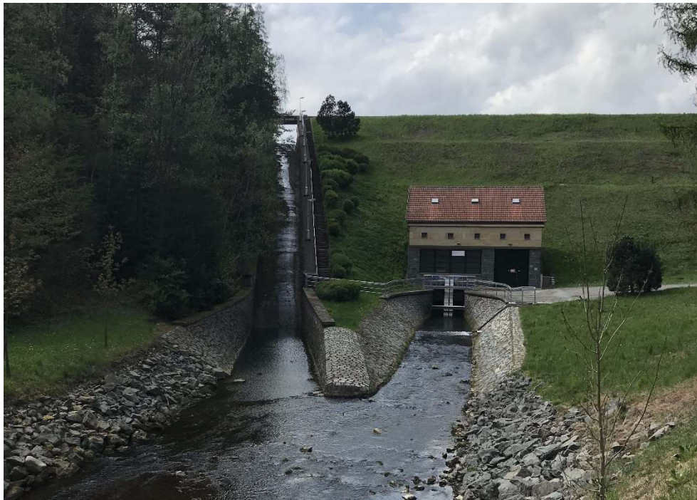
Obr. 2.14 Protivodní pohled na hráz s funkčními objekty
