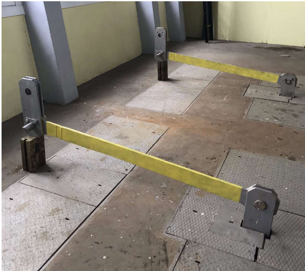
Obr. 2.10 Soutyči revizních uzávěrů spodních výpustí
