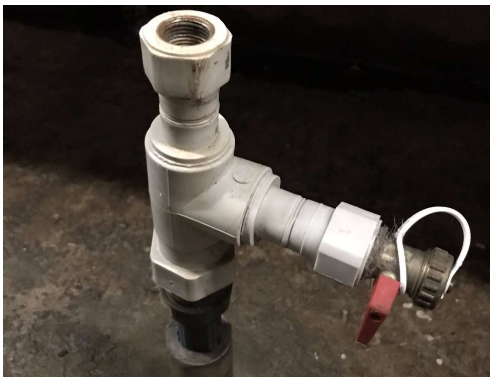
Obr. 2.29 Zhlaví tlakoměrného vrtu V6 v chodbě spodních výpustí
