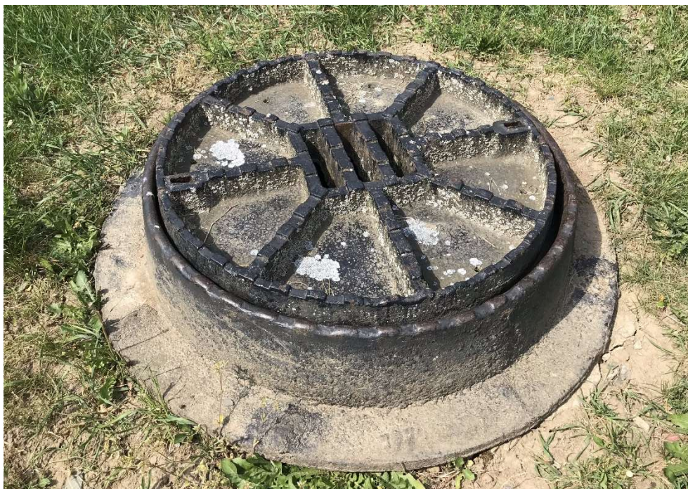
Obr. 2.26 Kontrolní šachta KŠ3
