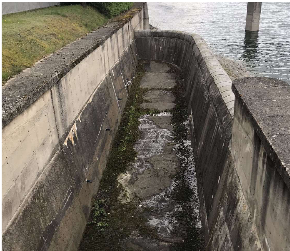
Obr. 2.12 Bezpečnostní přeliv se spadištěm
