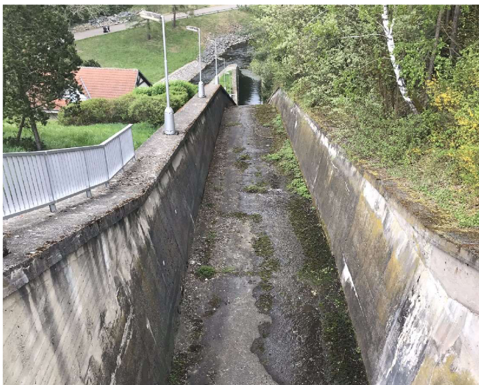
Obr. 2.13 Skluz pod spadištěm
