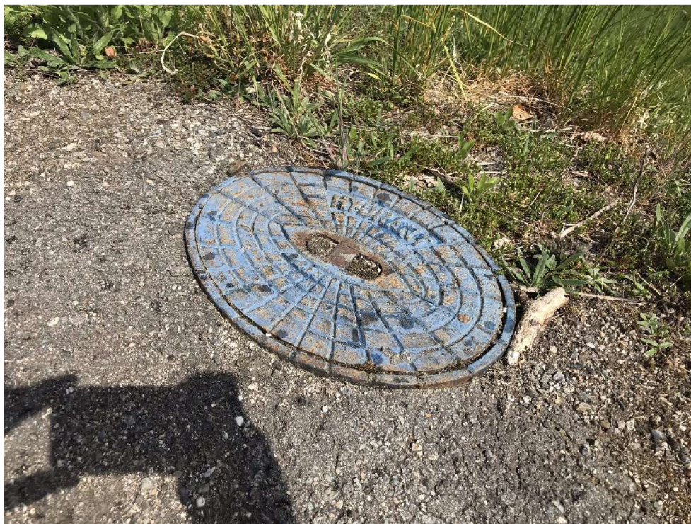
Obr. 2.33 Poklop nivelačního bodu K12 při vzdušní straně
