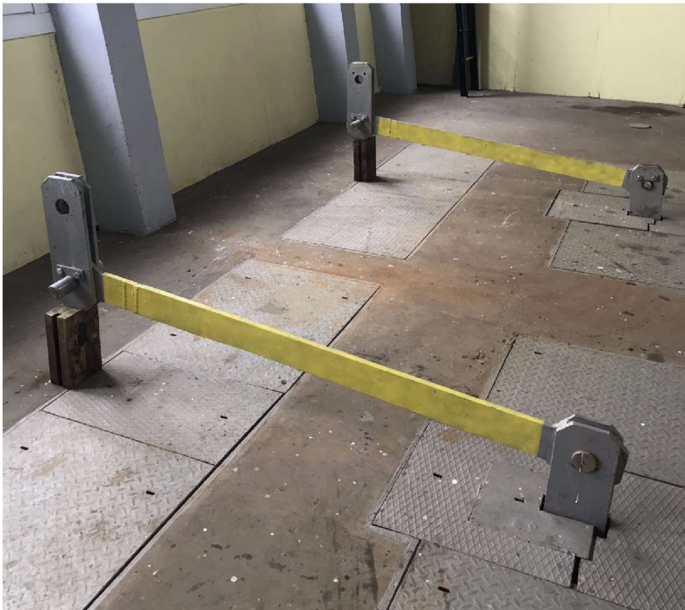
Obr. 2.10 Soutyči revizních uzávěrů spodních výpustí
