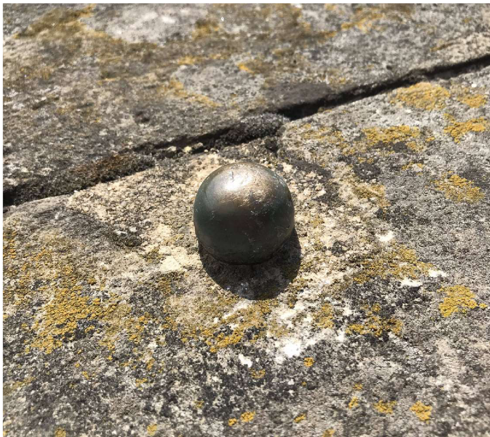
Obr. 2.32 Kontrolní nivelační bod K1 na vlnolamu
