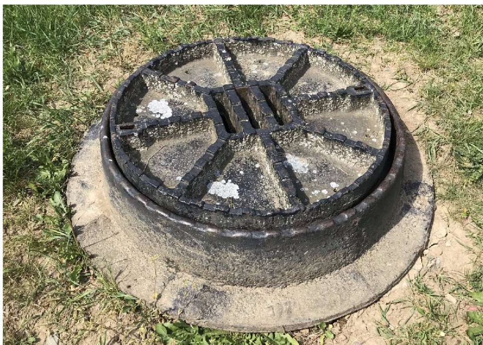
Obr. 2.26 Kontrolní šachta KŠ3
