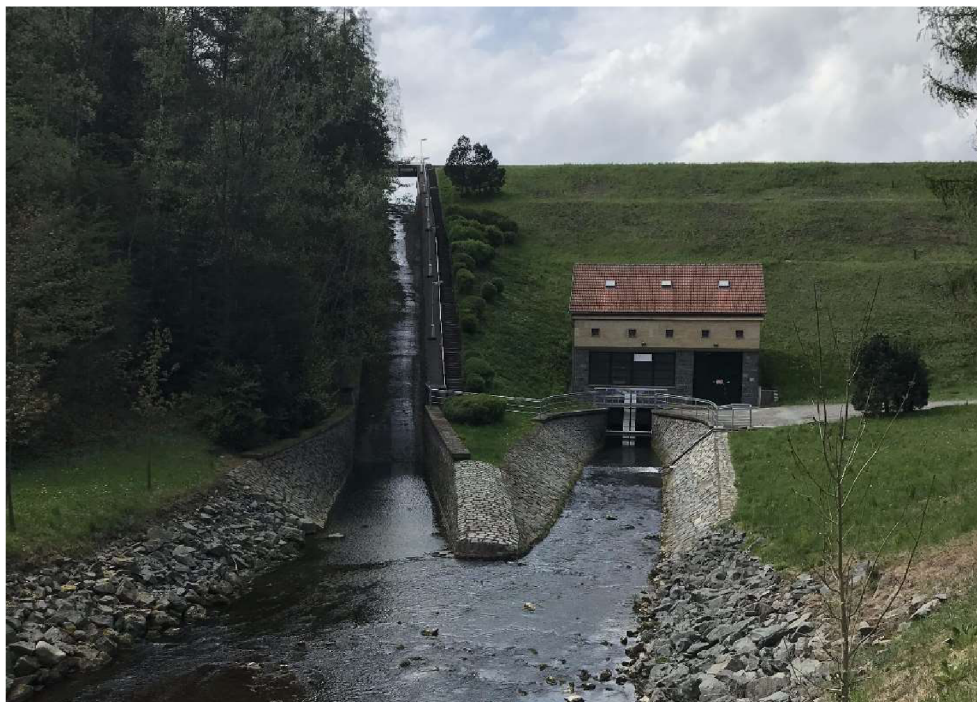
Obr. 2.14 Protivodní pohled na hráz s funkčními objekty
