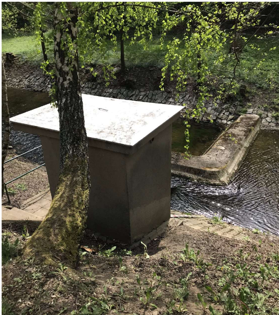
Obr. 2.17 LG Letovice pod hrází a upravené koryto toku
