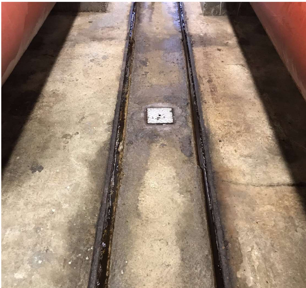
Obr. 2.34 Poklop nivelačního bodu 12 v chodbě spodních výpustí
