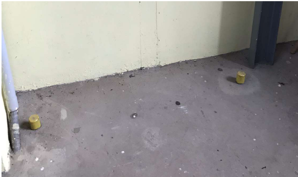
Obr. 2.37 Klínometrická základna KL1 v odběrné věži se zakrytými body
