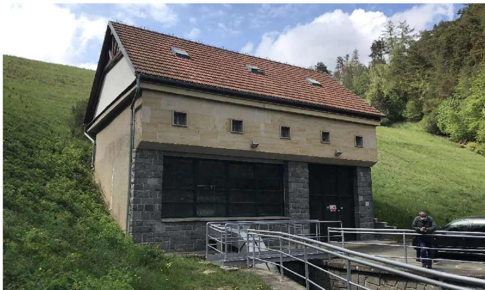
Obr. 2.15 Objekt MVE spolu se strojovnou spodních výpustí
