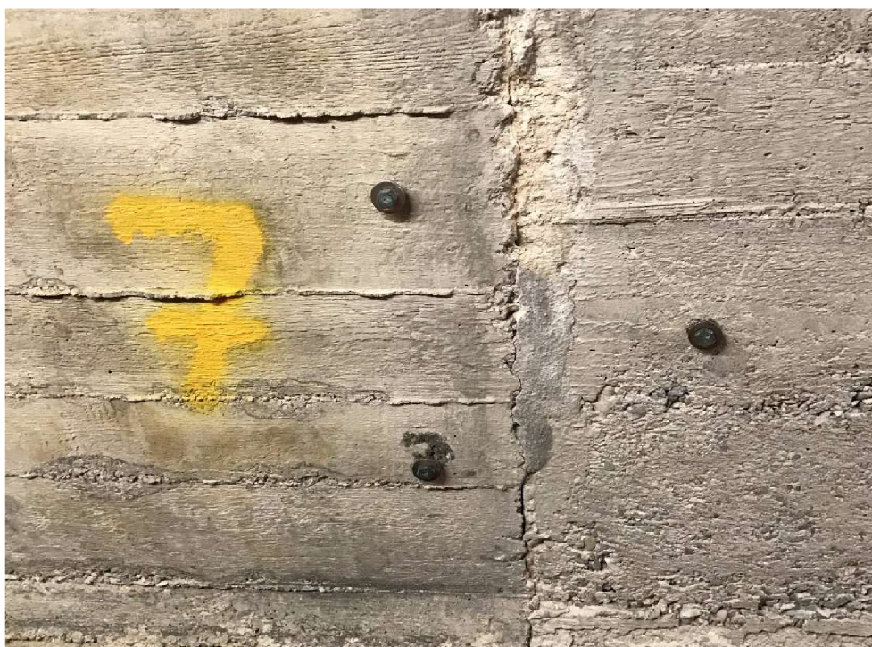
Obr. 2.36 Deformetrická základna D7
