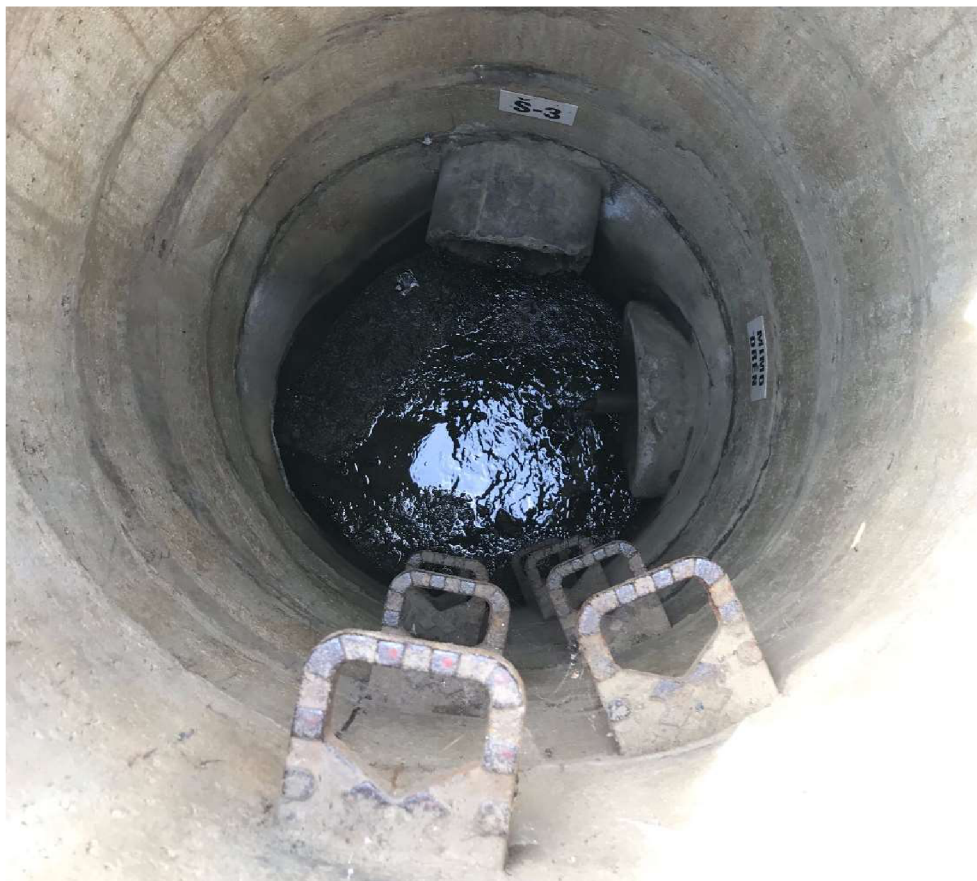
Obr. 2.27 Pohled do kontrolní šachty KŠ3
