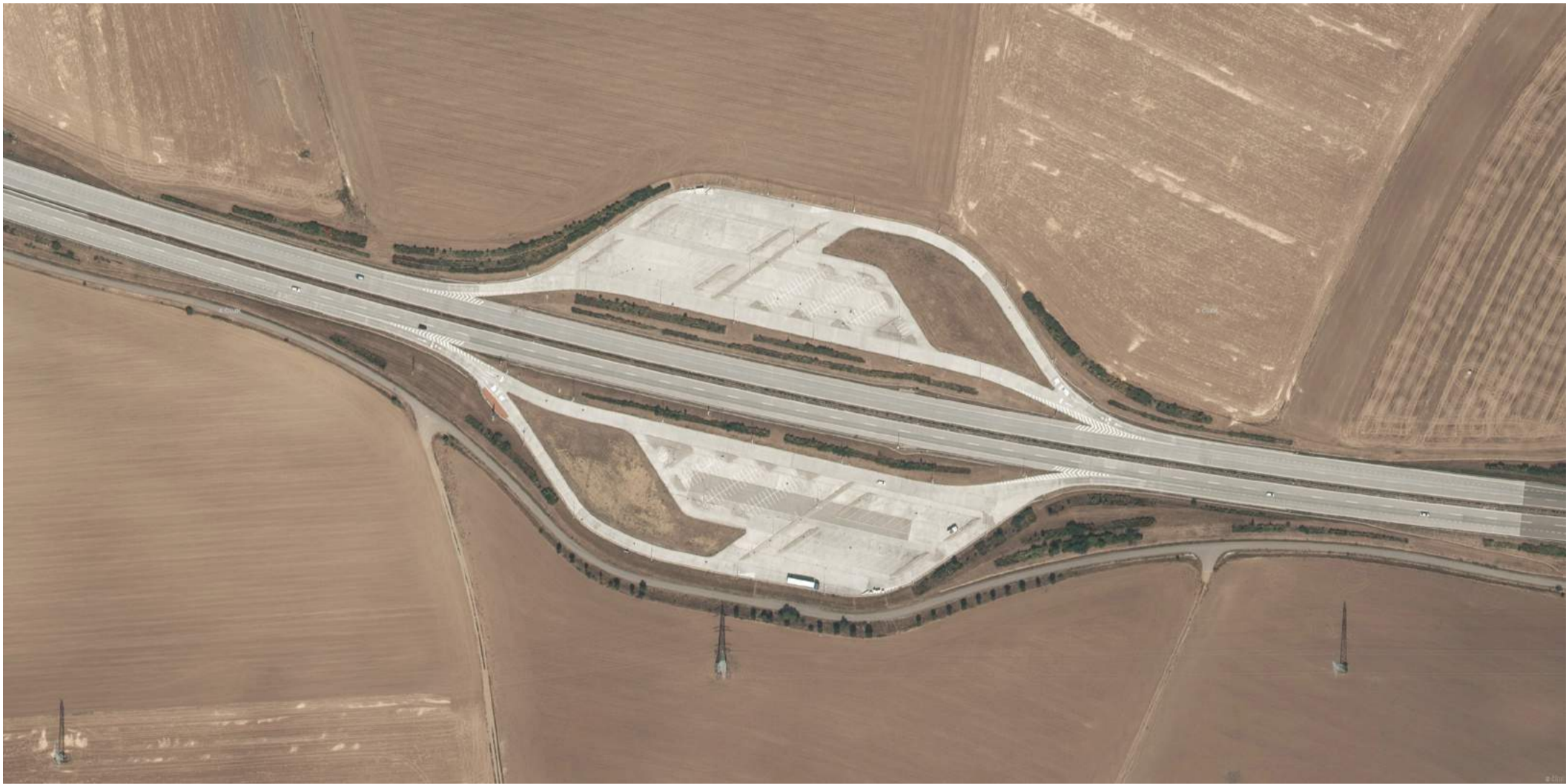
Ortofotografie odpočívky Křenovice, která je v provozu od dubna 2016. Stav v roce 2018. Zdroj ČÚZK.
