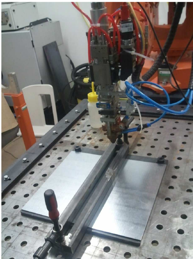
Obr. 42 Upnutí překlátovaných pozinkovaných plechů pomocí přípravku
