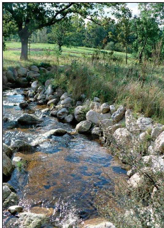
Obr. 14. Obtokový kanál – zpevnění břehu kameny (Marek, 2013)
