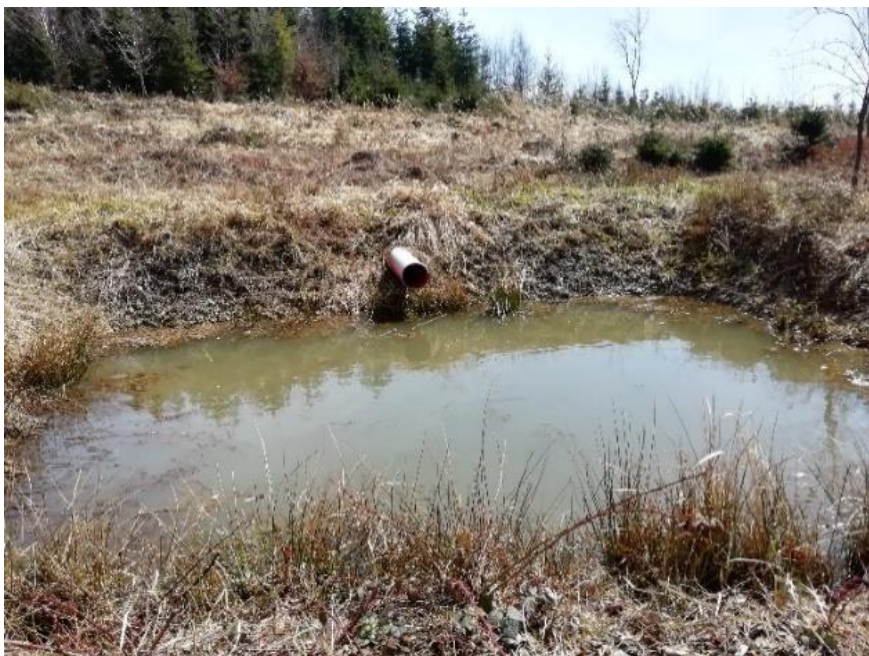
Příloha č. 10: Vsakovací objekt podzemních vod s nálezy snůšek skokana štíhlého ( Rana dalmatina ). Rezervoár slouží k usměrňování a nasakování vody v rámci lesních cest (fotografie pořízena 9. 4. 2021).
