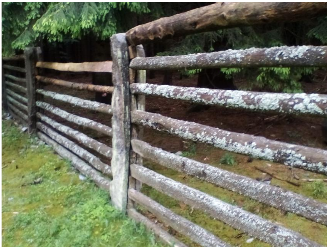
Obr. č. 8: Oborní oplocení s původními sloupky
