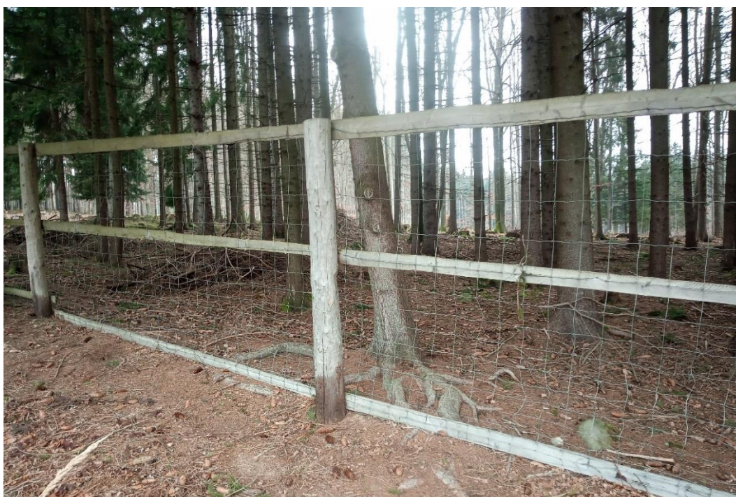
Obr. č. 9: Část plotu s dubovými sloupky a oborním pletivem
