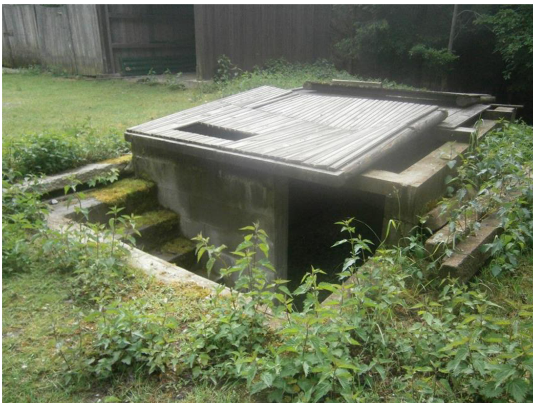
Obr. č. 13: Krechl v Roštejnské oboře před rekonstrukcí
