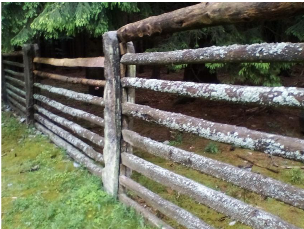
Obr. č. 8: Oborní oplocení s původními sloupky
