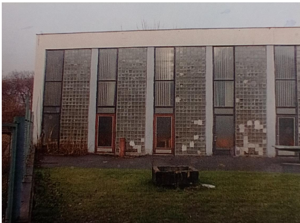
17 Vojtěch Šalda, Základní škola Petra Strozziho – jídelna, 1966.
