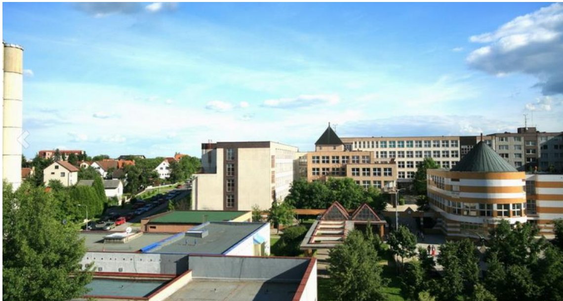
48 Zdeněk Hölzel – Jan Kerel, Fakultní základní škola Barrandov II (před rekonstrukcí), 1992.
