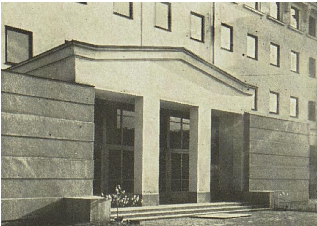
5 František Marek, Základní škola Jakutská – hlavní vstup, 1955.
