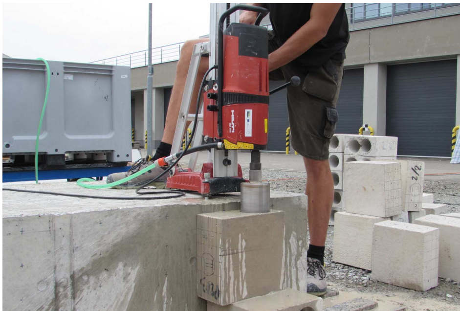
Obr. P10: Jádrové vrtání
