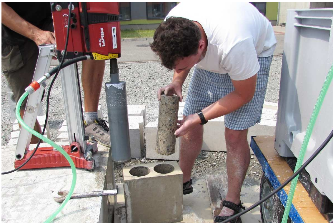
Obr. 20: Odběr jádrového vývrtnu
