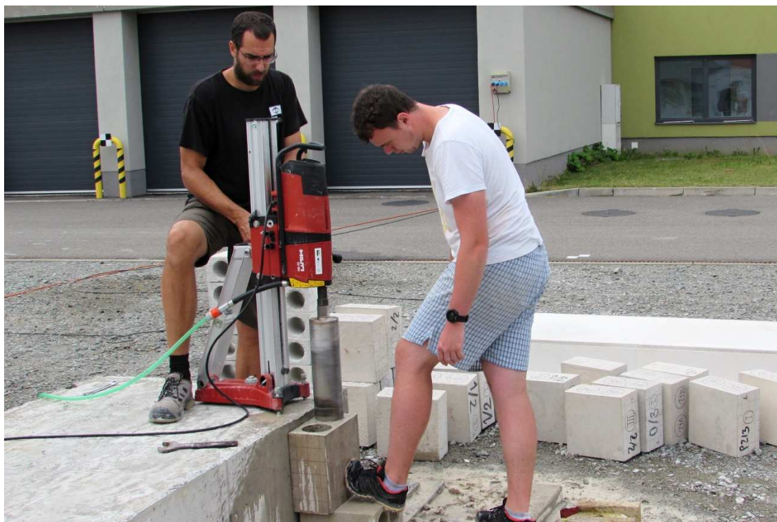
Obr. 35: Práce s jádrovou vrtačkou
