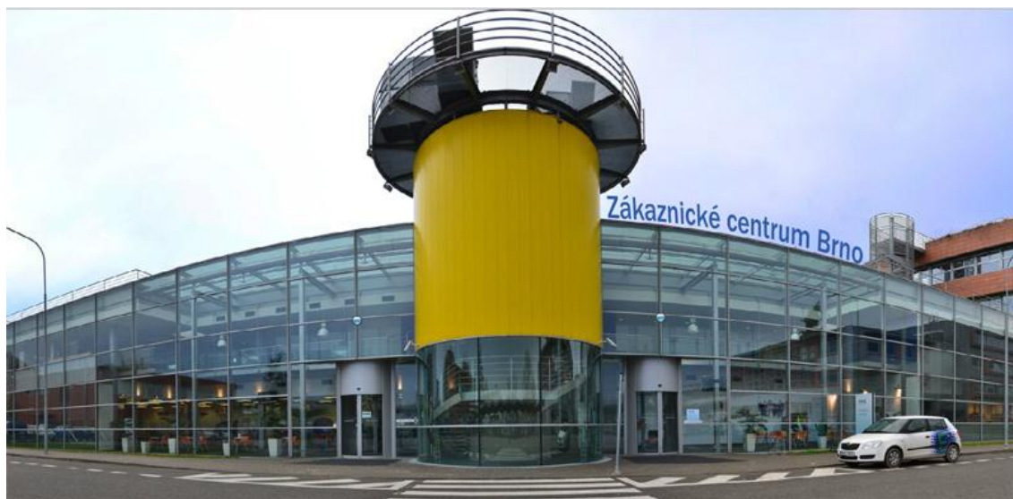
Obr. 10 Vchod zákazníckeho centra
