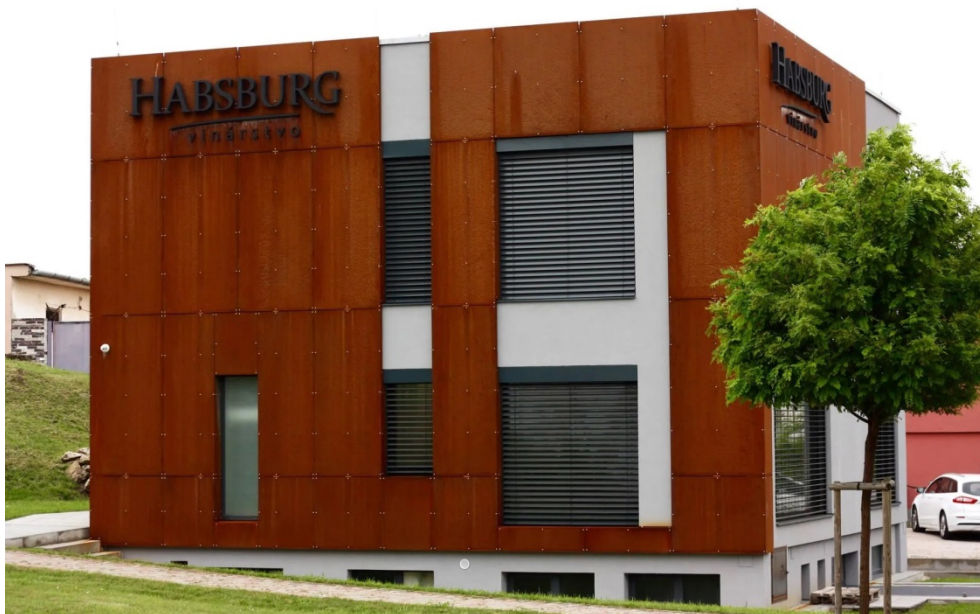
Obr. 2. Použití materiálu Cor-ten na fasádu (Archiweb, 2022)
