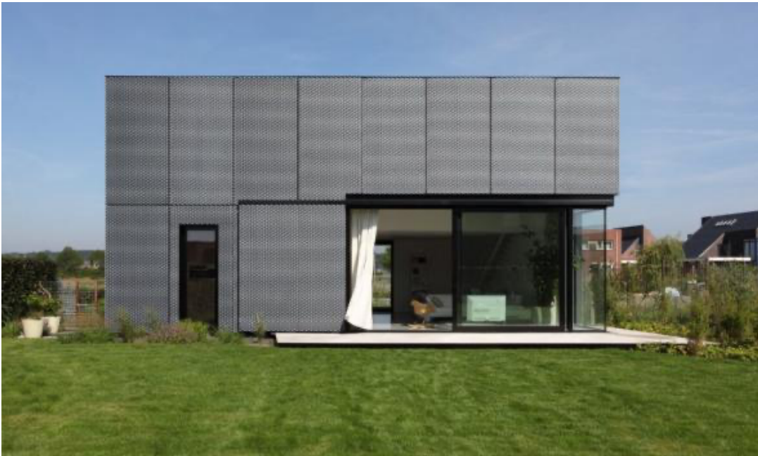
Obr. 1. Použití materiálu tahokov na fasádu (Adgnews, 2022)
