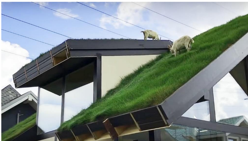
Obr. 3 Ozelenění šikmé zelené střechy (MT-M Heat Insulation ©2020)
