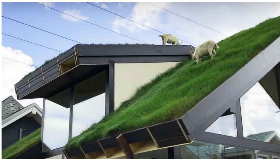
Obr. 3 Ozelenění šikmé zelené střechy (MT-M Heat Insulation ©2020)
