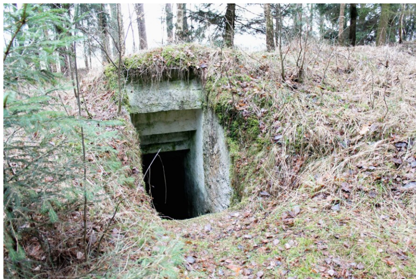
Foto 4: Bunkr před rekonstrukcí
