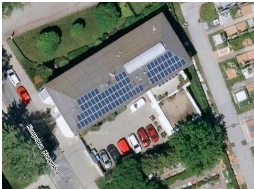
Obrázek 19 - Pohled na FVE
