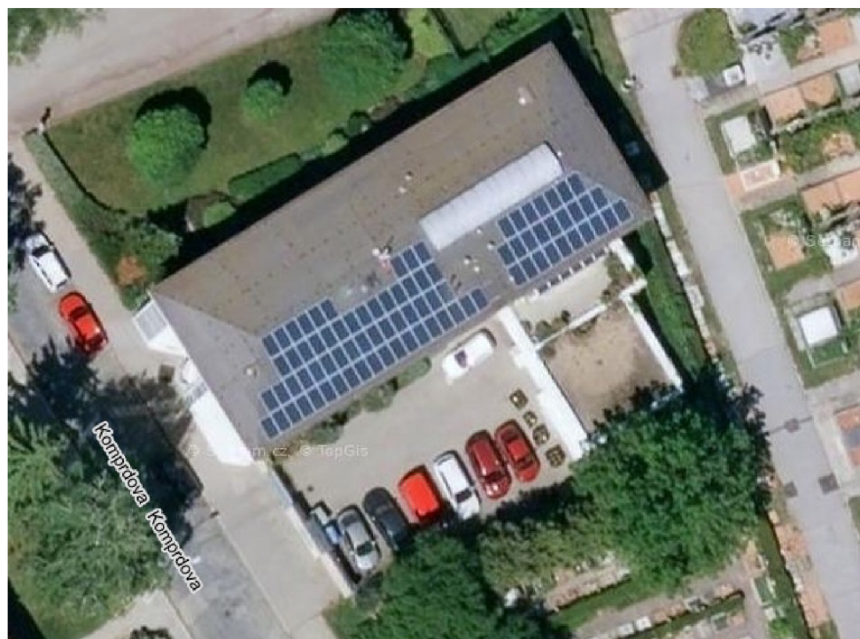
Obrázek 19 - Pohled na FVE
