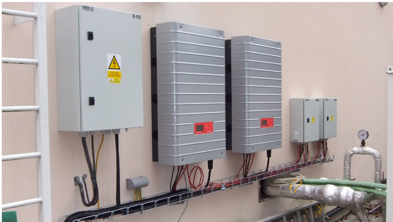
Obrázek 22 – Umístění střídačů
