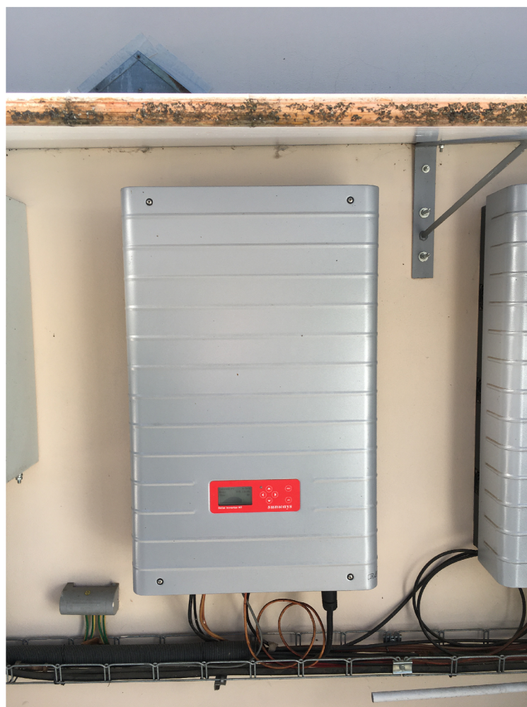
Obrázek 23 – Detail střídače
