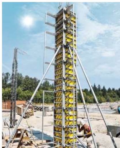
Obr. 56 – Bednění sloupu DOKA [25]
