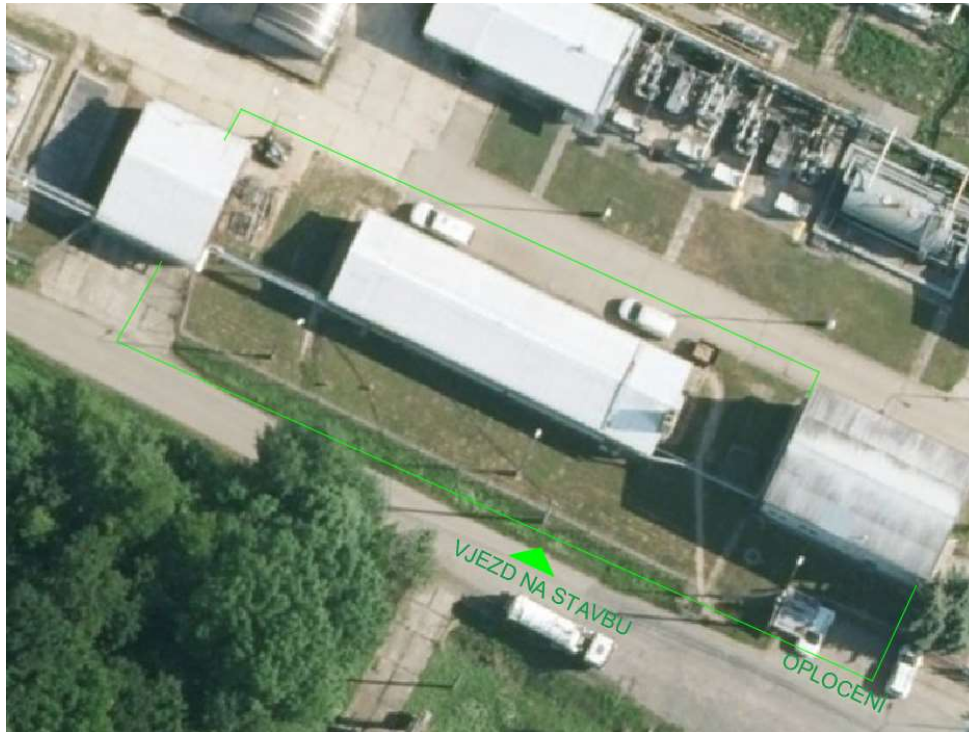
Obr. 3 – Pohled na staveniště [3]
