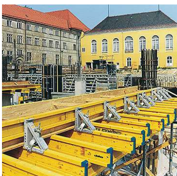
Obr. 55 – Bednění stropu DOKA [25]
