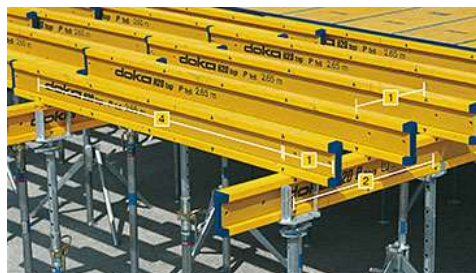
Obr. 55 – Bednění stropu DOKA [25]
