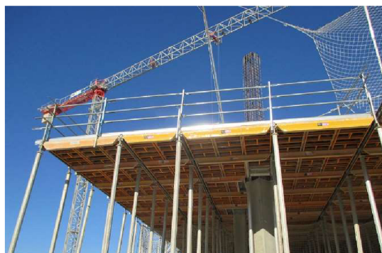
Obr. 72 - Zábradlí bednění [25]
