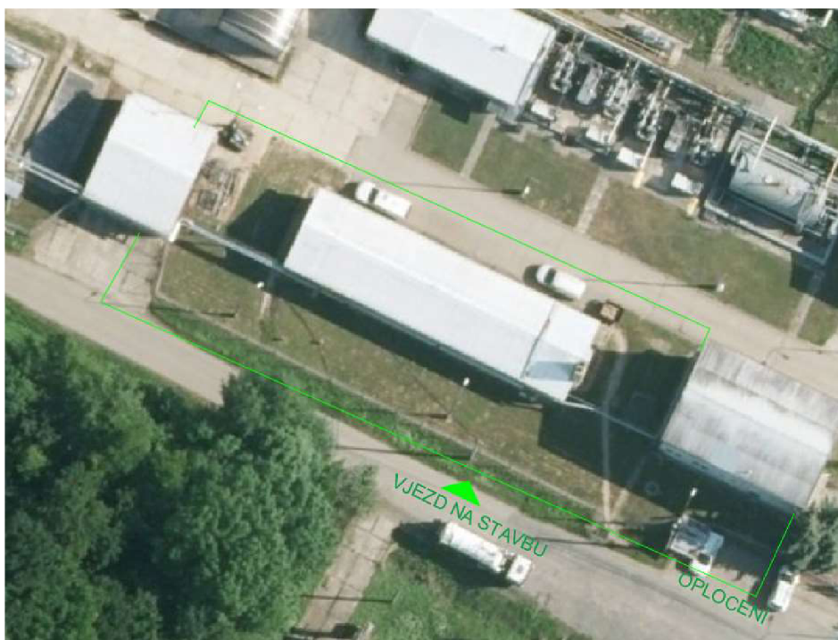
Obr. 3 – Pohled na staveniště [3]
