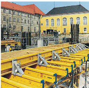
Obr. 55 – Bednění stropu DOKA [25]
