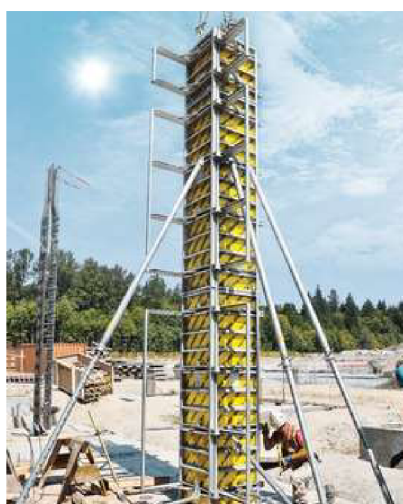
Obr. 56 – Bednění sloupu DOKA [25]
