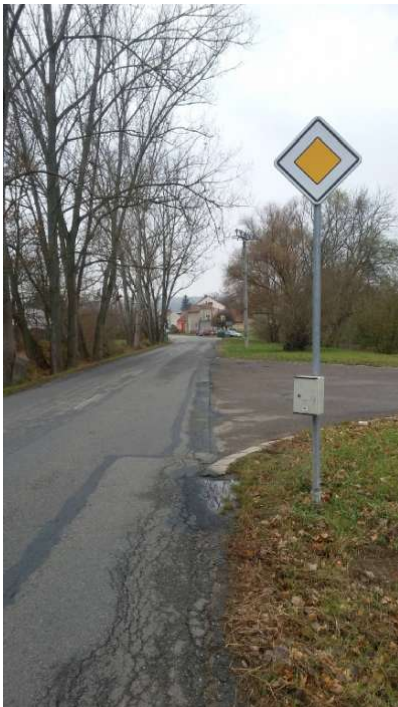
Obr. 11 – Ul. Kohoutovická – osazení radaru
