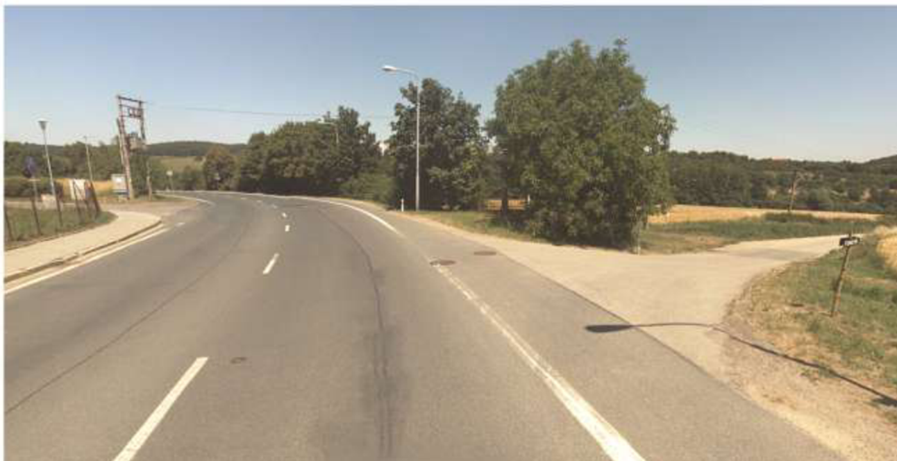
Obr. 1 – Ul. Hostislavova směrem na Bystrc (vpravo komunikace k budoucí obytné zóně, vlevo jednosměrná ulice Chrprová)
