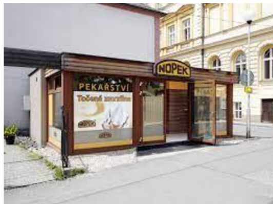
Obrázek 49 Zrekonstruovaná prodejna na zastávce
