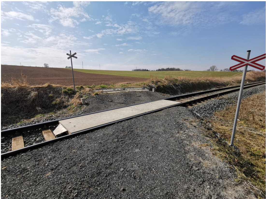
Obrázek č. 46 železniční přejezd zajišťující přístup k p. b 2605/5
