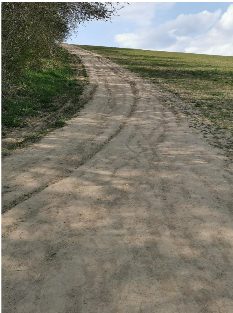
Obrázek č. 5 příklad rýžkové eroze - foto autor
