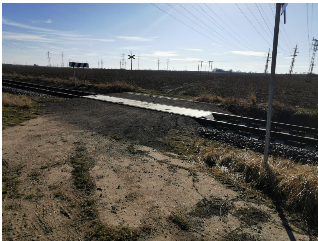
Obrázek č. 42 přejezd pro zem. techniku k p. bloku č 9802/2
