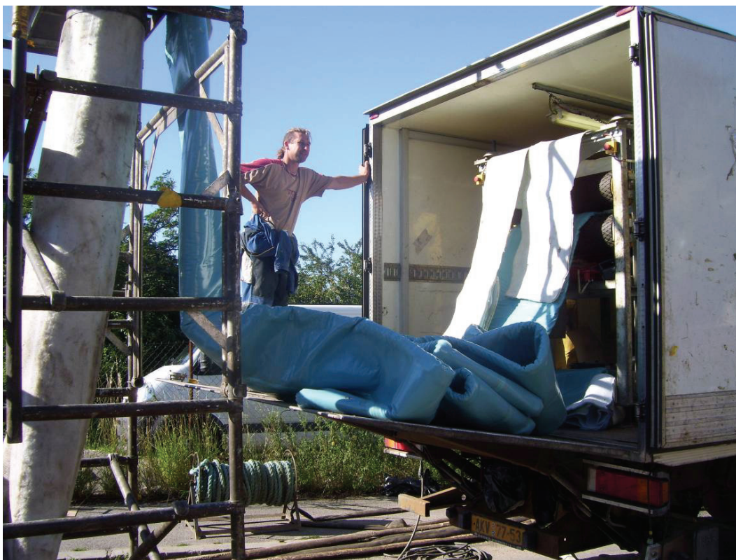
Obr. 25 - Nasycená část rukávce po průchodu plnicí linkou. Vlevo je vidět inverzní věž se zaváděcím rukávцем zajišťujícím potřebný vodní sloupec. Zdroj: autor 2009
