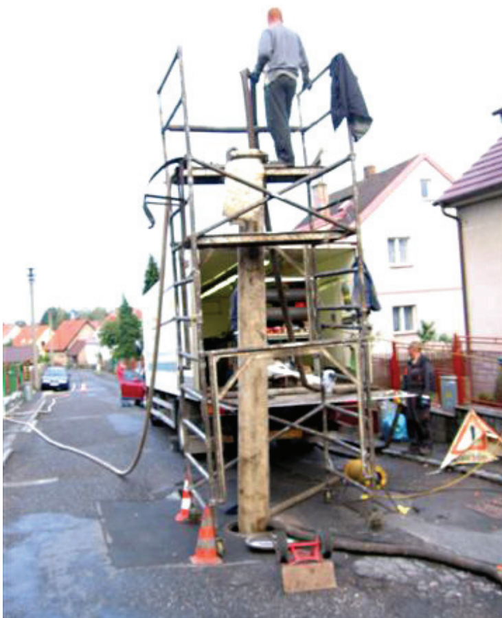
Obr. 27 - Inverzní věž po zatažení rukávce (pracovník drží topnou hadici). Zdroj: autor 2009
