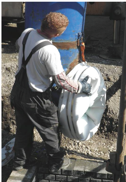
Obr. 29 - Otočení rukávce naruby (inverze rukávce), před zatahováním. Zdroj: autor 2011
