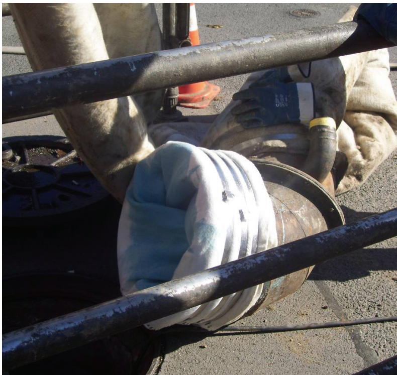
Obr. 26 - Inverzní koleno s naruby převráceným, nasyceným rukávem připraveným k zatažení.
