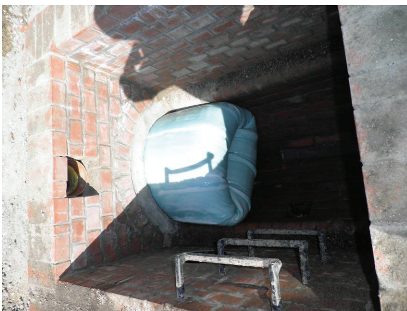
Obr. 30 - Zatahování rukávce, průchod průběžnou šachtou. Zdroj: autor 2011
