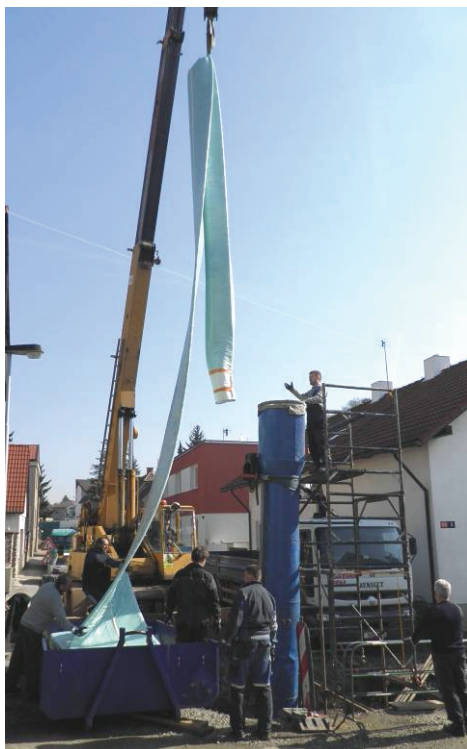
Obr. 28 - Protažení začátku rukávce zaváděcí lafetou. Zdroj: autor 2011
