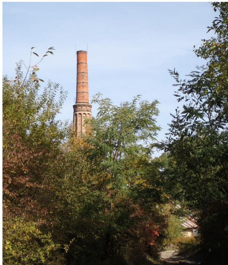
Obr. 4 Bývalá vápenka v Grygově (foto: Anežka Brhlíková, 2013)
