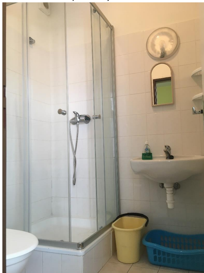
Obrázek č. 4 – Koupelna v bytě č. 5 DNPC
