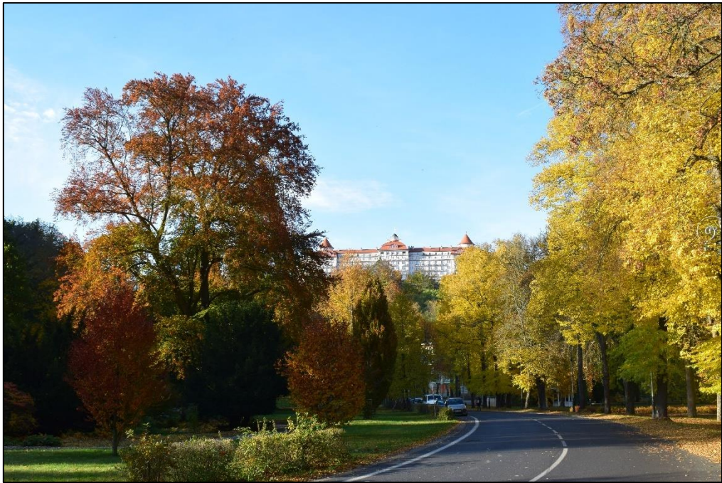
Fotografie XVI: Podzimní pohled na hotel Imperial a pozemní komunikaci protínající Sady u Poštovního dvora (Klich, 2020)
