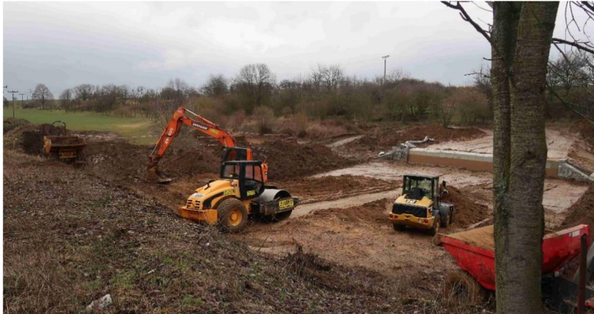
Obrázek 15: Výstavba protierozního poldru v k. ú. Chorušice
