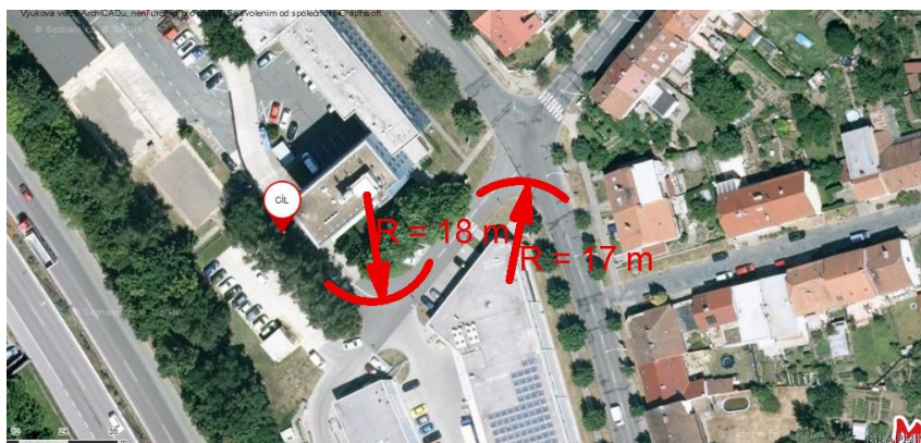
Obrázek 3-6 Příjezd na staveniště [1]
