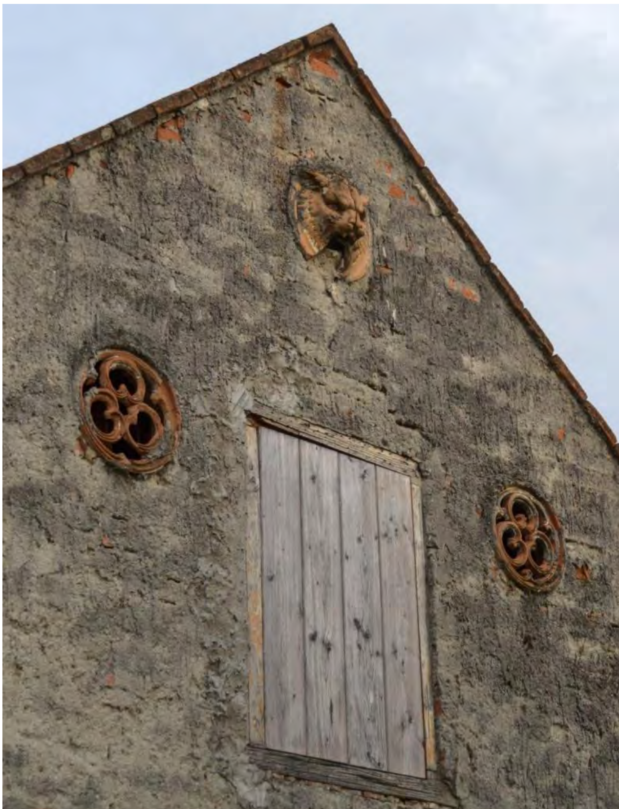
Obrázek 45 Výrobky poštorenské keramičky, jež jsou výrazným fenoménem LVA, se uplatňují nejen na bývalých knížecích a veřejných budovách, ale i na domech obyčejných lidí. Pálená hlína je tak v LVA téměř všudypřítomná (Lednice, ulice Cihlářská, foto J. Dohnal, 2014).
