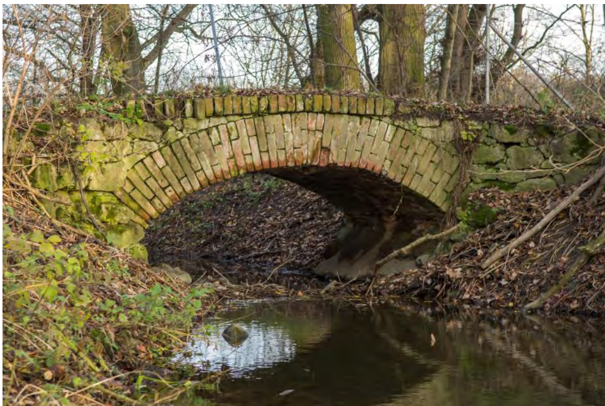
Obrázek 37 Cihlový klenutý most přes kanál odvádějící vodu z Růžového rybníka na hranici lednického parku fixuje starou manýristickou, barokní a klasicistní kompozici - roh obory Hvězda a hranici bývalého lesního porostu (foto J. Dohnal, 2014).
