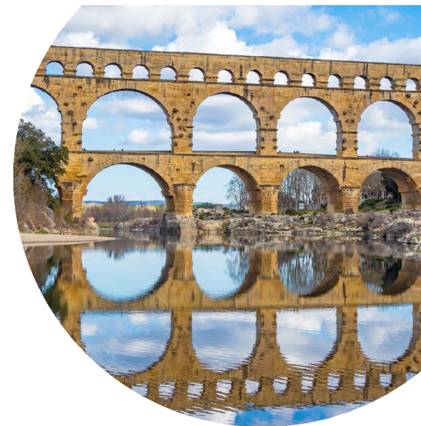
Obrázek č. 3 - Aquadukt (Zdroj: https://www.shutterstock.com/cs/search/aquadukt )
