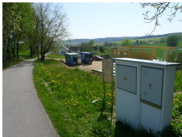
Foto 2: Výstavba v severní části obce Habří
