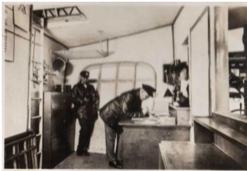
Obr. 3-8 Navigační místnost s žebříkem ústícím do kýlové chodby [6]
