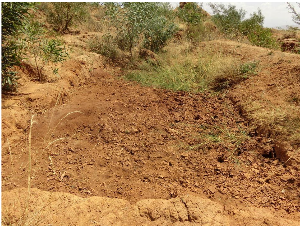
Obr. 5 Zanesený zasakovací rybníček (Foto autor práce)
