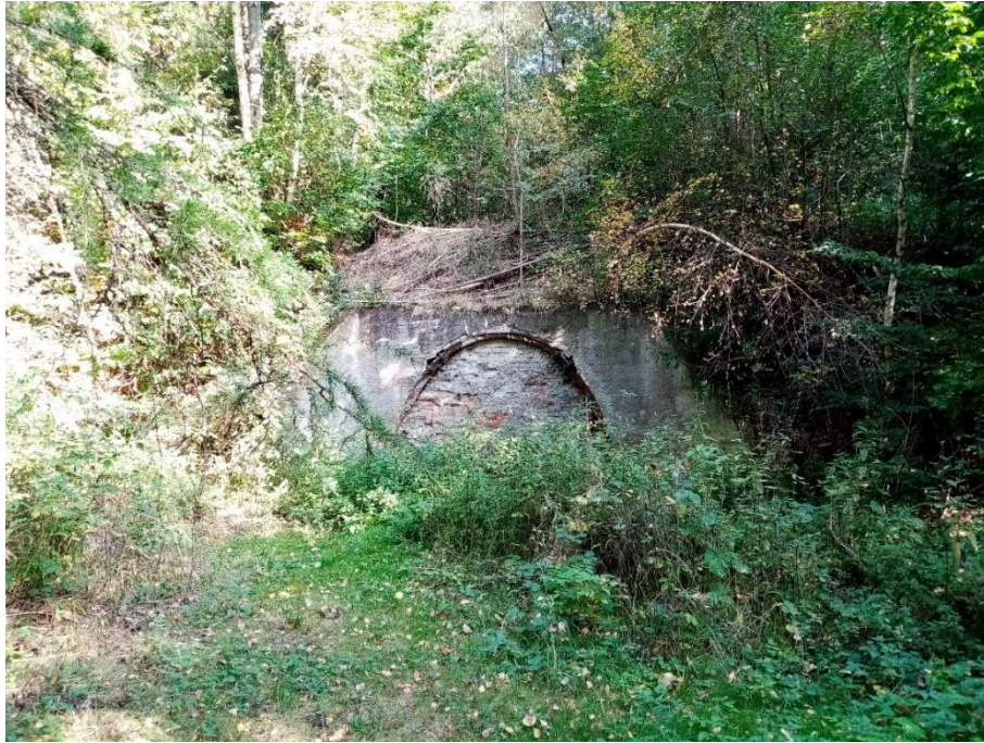
Obr. 8: Zazděný vstup do štoly Jindřich, Dětkovice (foto Kvaltinová, 2022).
