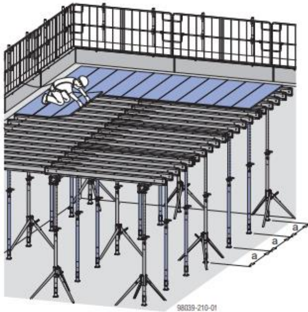
Obrázok 72: Pokladanie debniacich dosiek a zhotovenú podpornú konštrukciu stropného debnenia [29]
