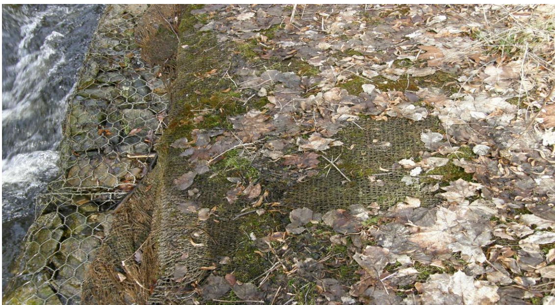
Obrázek č. 16 – Přírodě blízké drátošterkové koše – zpevnění břehů pod III. Mlýnem – nad nimi jsou kokosové rohože (foto Povodí Ohře, 2008)
