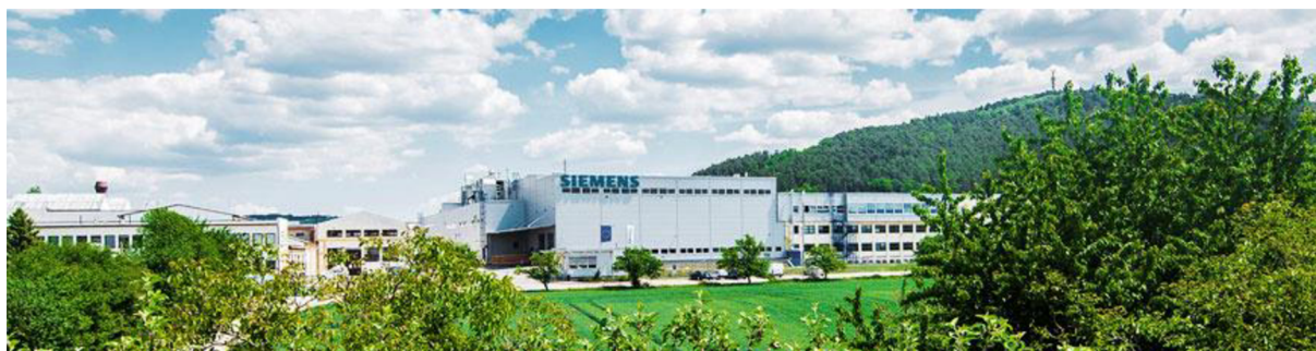
Obr. 8) Siemens Electric Machines s.r.o. v Drásově [19]
