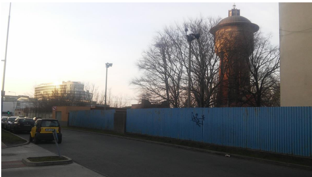
Obr. č. 9: Kotěrova vodárenská věž a její okolí, pohled od nové výstavby
