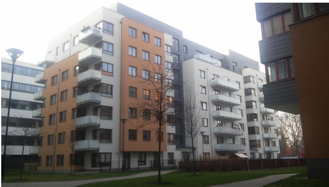
Obr. č. 6: Obytný dům, pohled od objektu A1
