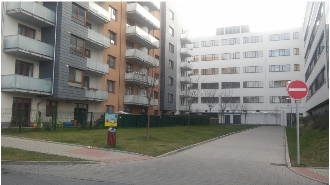
Obr. č. 7: Obytný dům a stávající objekt Pankrác a.s. pohled z ulice
