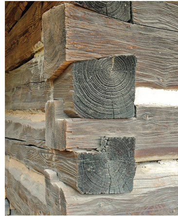
Obrázek 27: Kombinace zámkového spoje (dole) a rybinového (nahore) v roubence na Plzeňsku.
