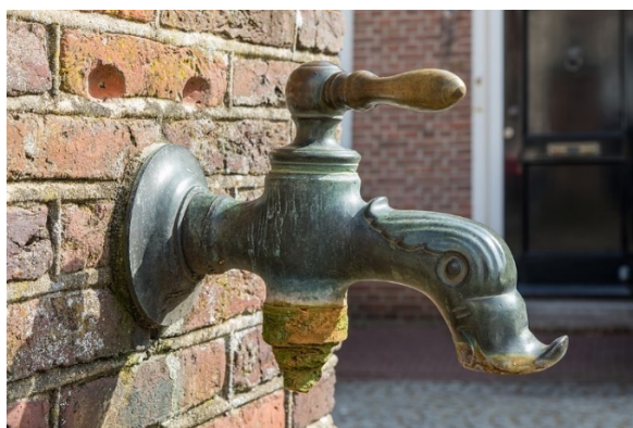
Obrázek 6 (vlevo): je příkladem adaptivního jazyka forem vodovodního kohoutku, který je artikulovaným zakončením vodovodního porubí. Svou plasticitou vyjadřuje vztahy mezi částmi i vztah k lidské ruce na pohled příjemnou ergonomií páky.
