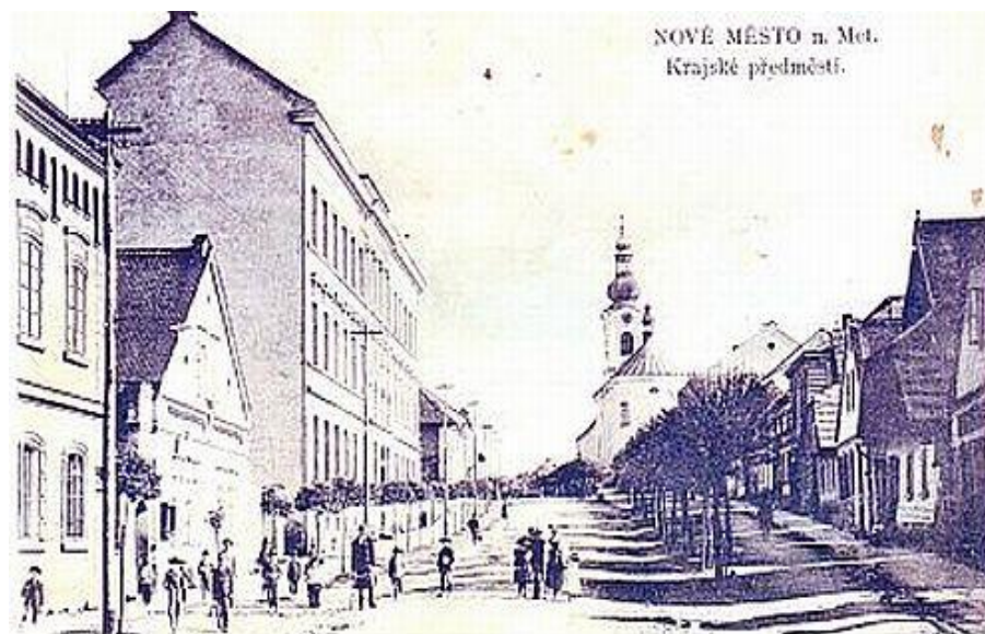
Obr. 5 – Základní škola s útulnou (DVOŘÁČEK, B. Pohledy do minulosti Nového Města nad Metují . Městský úřad, Městská knihovna a Městské muzeum v Novém Městě nad Metují, 2000. ISBN 80-238-5947-1. s. 218).
