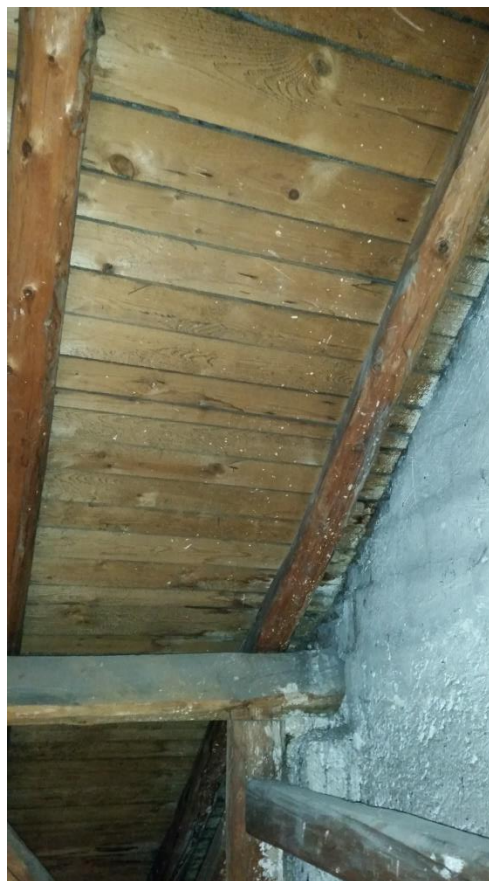
Obr. 3-7 Původní střešní konstrukce
