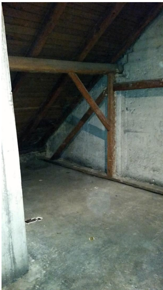
Obr. 3-4 Půda před zateplením podlah
