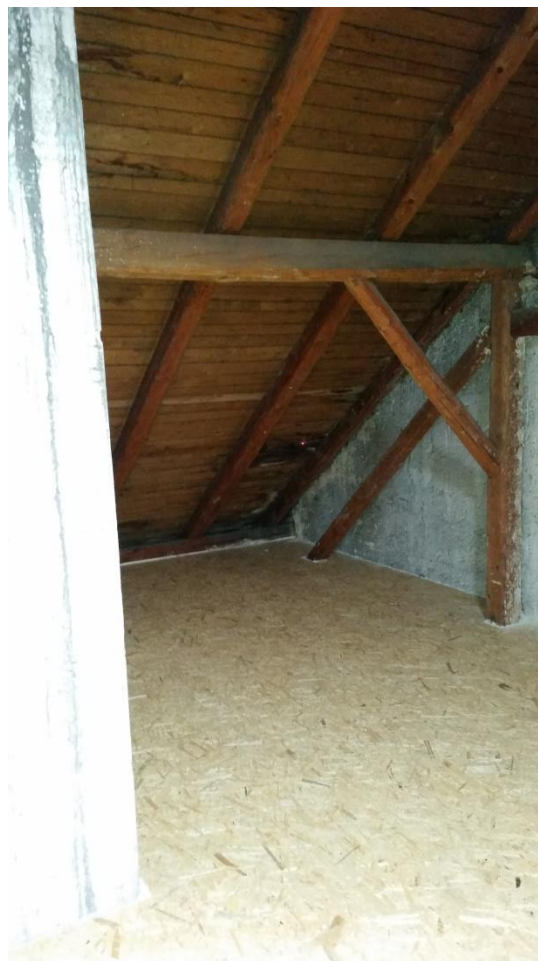
Obr. 3-5 Půda po zateplení podlah
