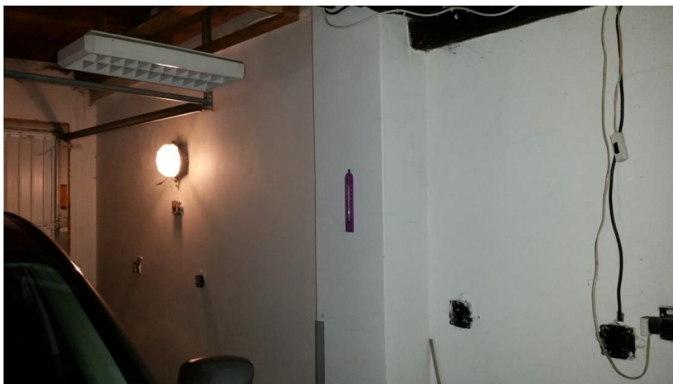
Obr. 3-3 Stěna garáže, která se bude zateplovat
