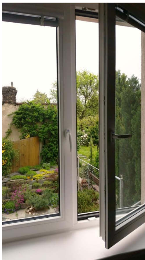
Obr. 3-2 Nové plastové okno Ok plast
