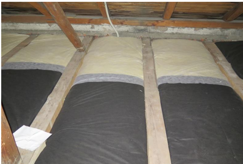
Obr. 3-8 Zateplení podlah v podkroví
