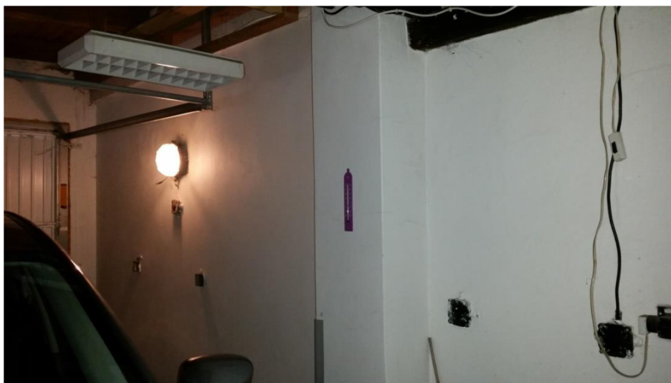
Obr. 3-3 Stěna garáže, která se bude zateplovat
