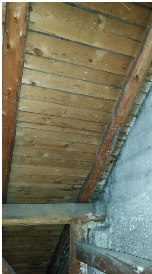
Obr. 3-7 Původní střešní konstrukce
