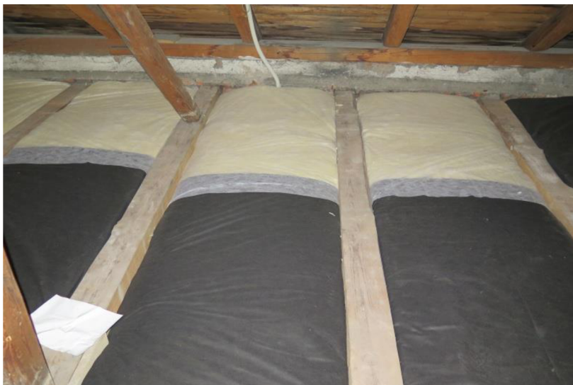
Obr. 3-8 Zateplení podlah v podkrovní
