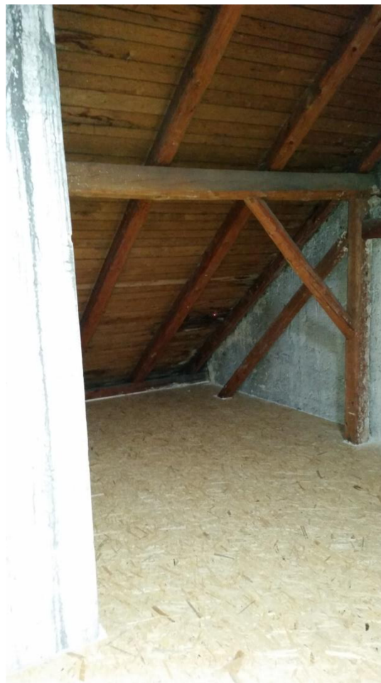
Obr. 3-5 Půda po zateplení podlah
