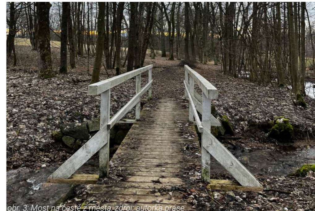
obr. 3: Most na cestě z města, zdroj: autorka práce
