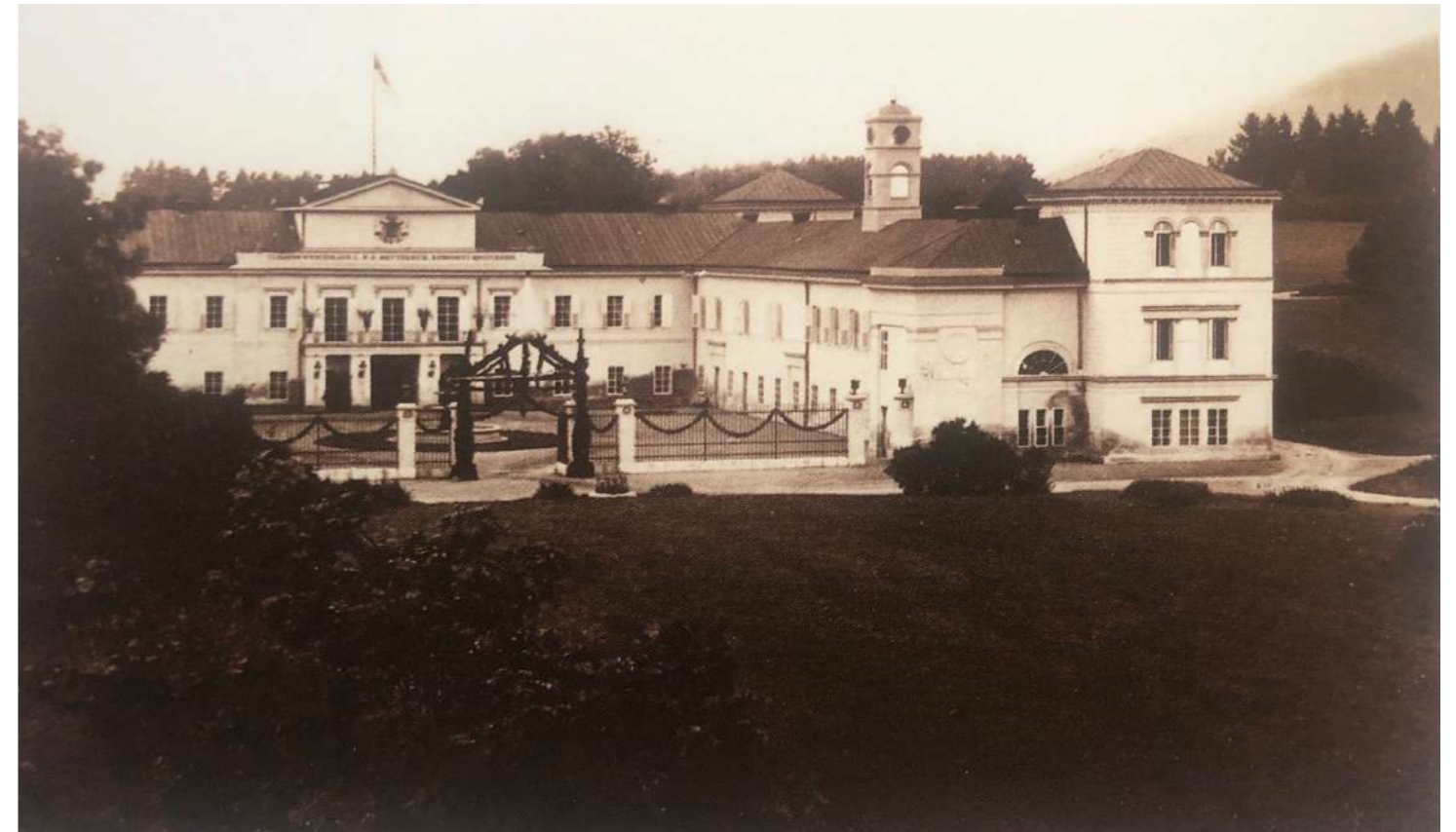
obr. 18: Pohled na vstup do zámku, zdroj: NPÚ
