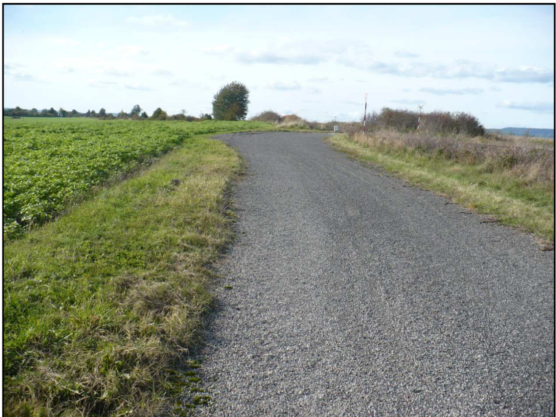
Foto 12 - Cestní síť – nová polní cesta NCH1 směrem k železnici, Oslí (Škabradová 2012)
