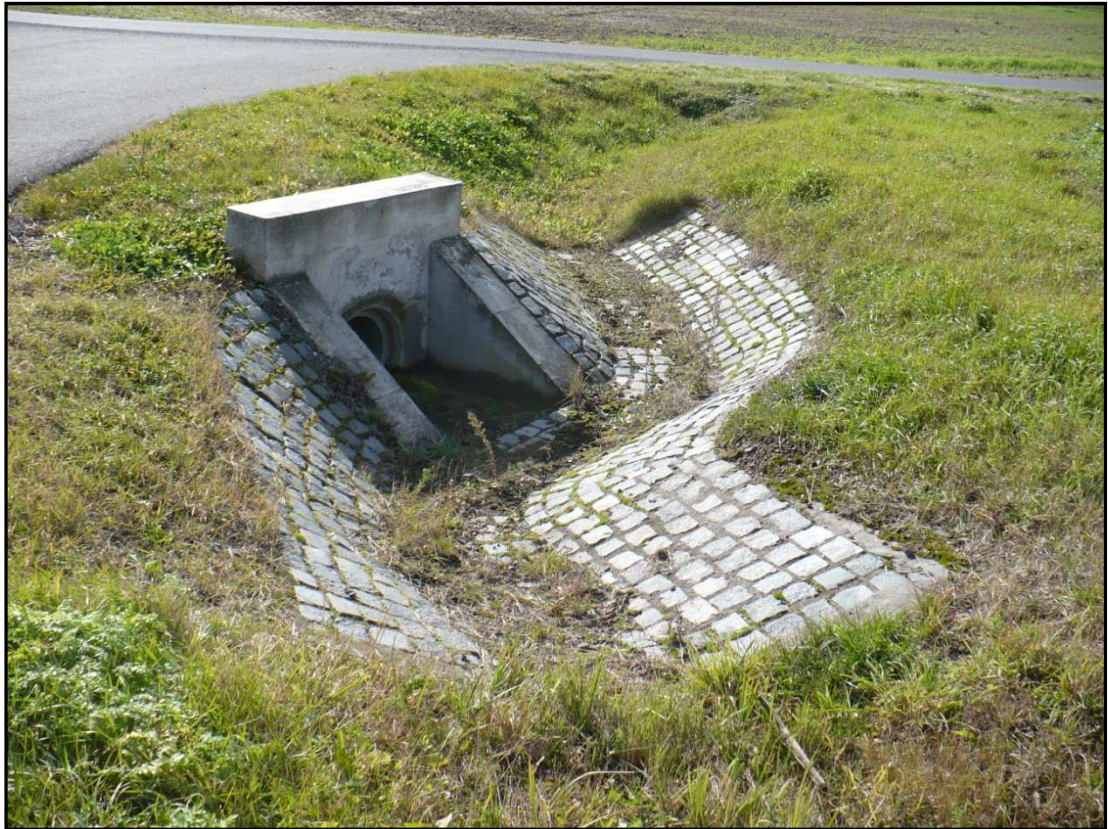
Foto 19 – Cestní síť – Propustek u polních cest RCV1 a NCV2, Chrást u Tochovic (Škabradová 2012)
