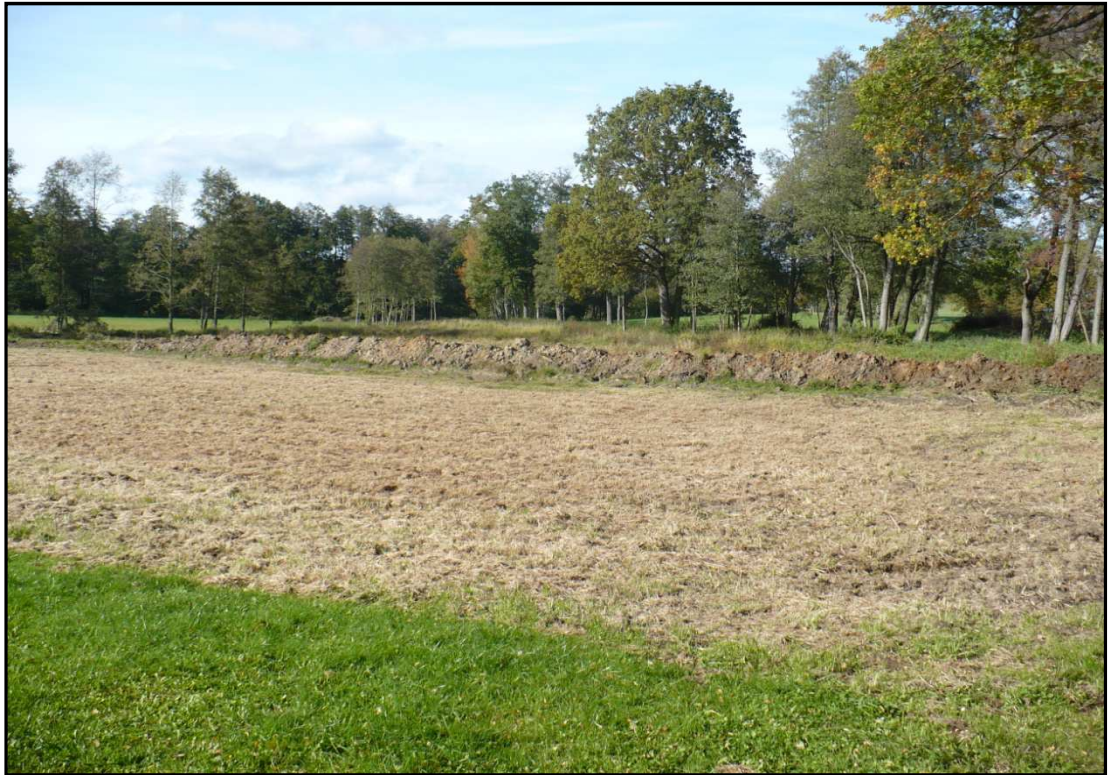
Foto 7 - Hydrologické opatření – obtokový kanál ve fázi realizace, Oslí (Škabradová 2012)
