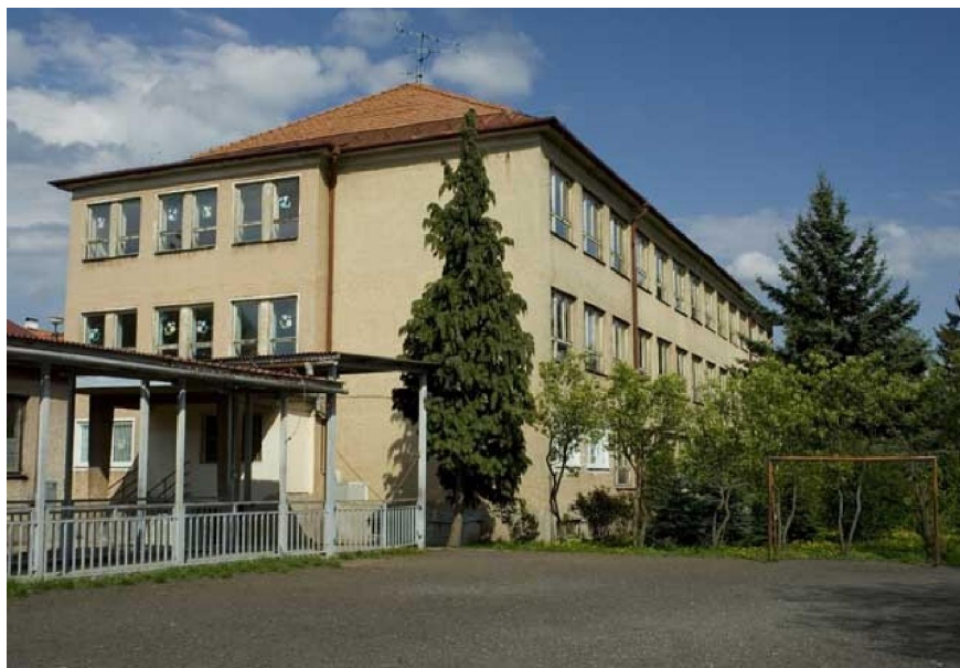
Obrázok 1: Základná škola Jozefa Horáka pred rekonštrukciou.
