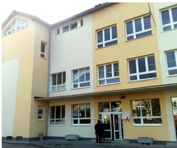
Obrázok 2: Základná škola po rekonštrukcii v septembri 2010.
