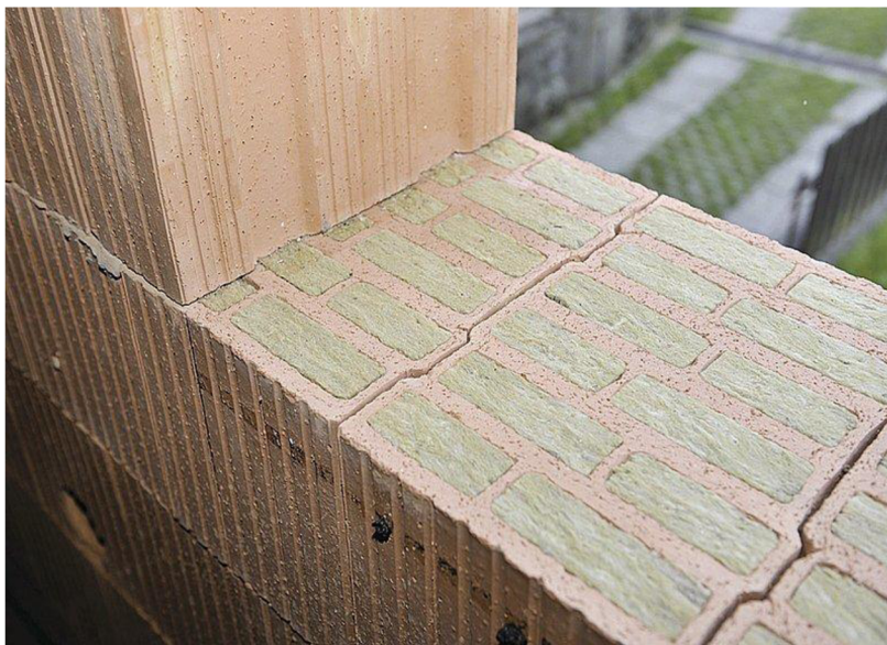
Obrázek č. 4 – Keramická tvarovka plněná minerální vlnou [36]
