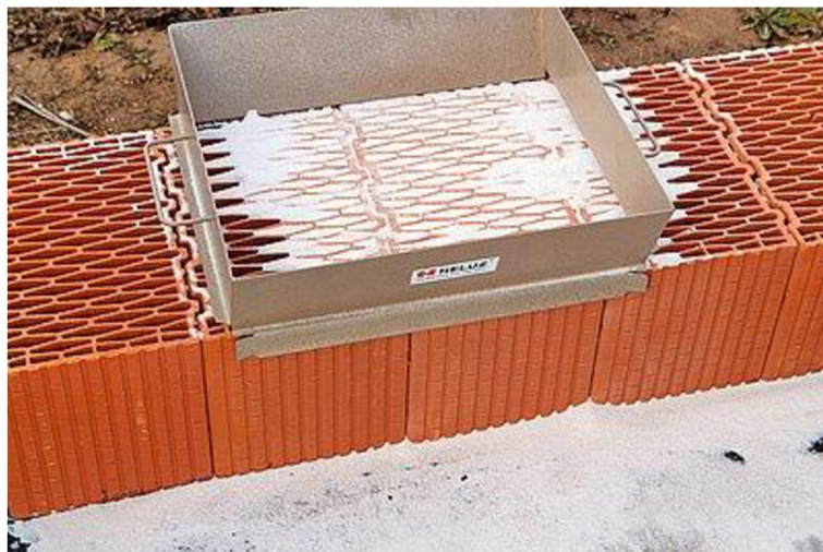
Obrázek č. 6 – Keramická tvarovka plněná perlitem [37]
